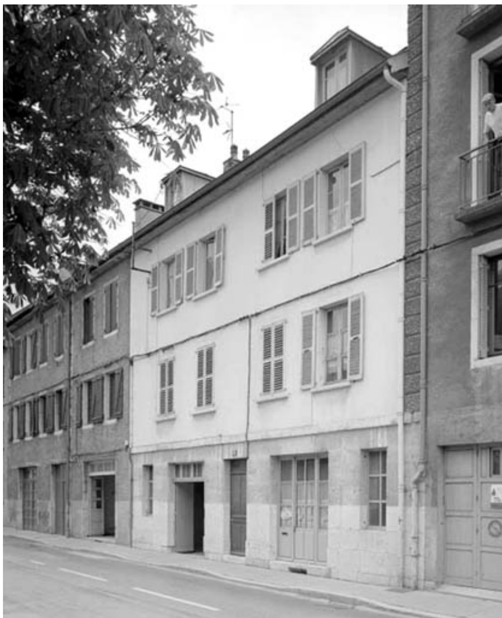
Façade antérieure de l'immeuble.
