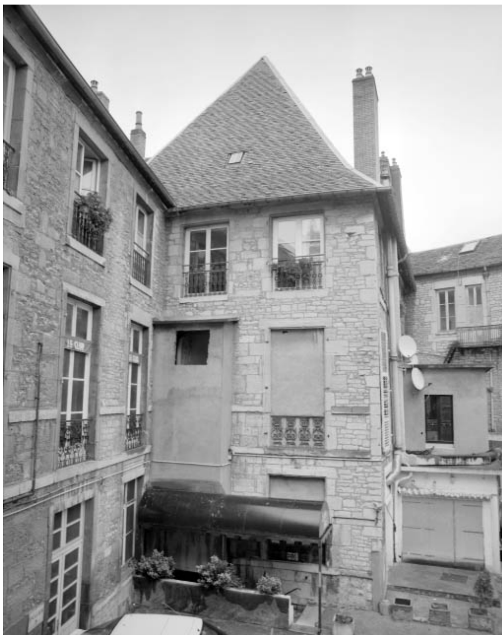
Logis sur cour : détail de l'avant-corps droit.
