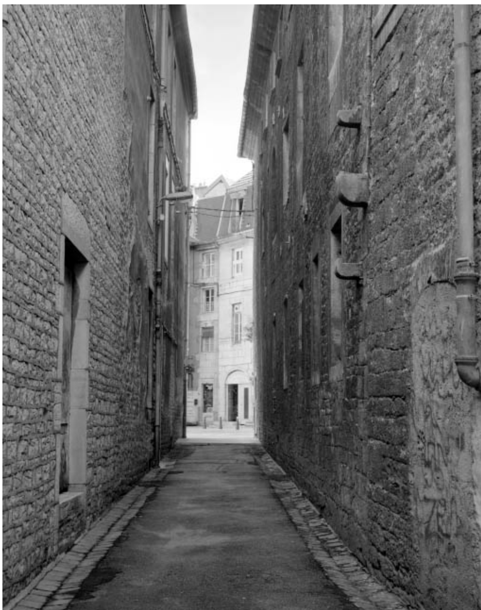
Façade latérale gauche : vue rapprochée.
