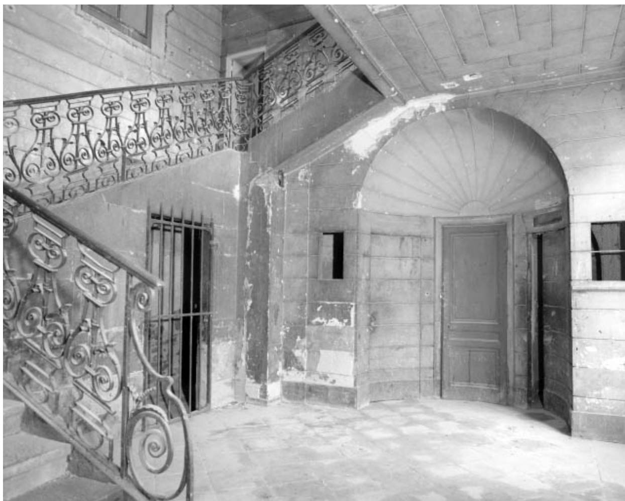
Intérieur : escalier d'honneur, vue d'ensemble en largeur.
