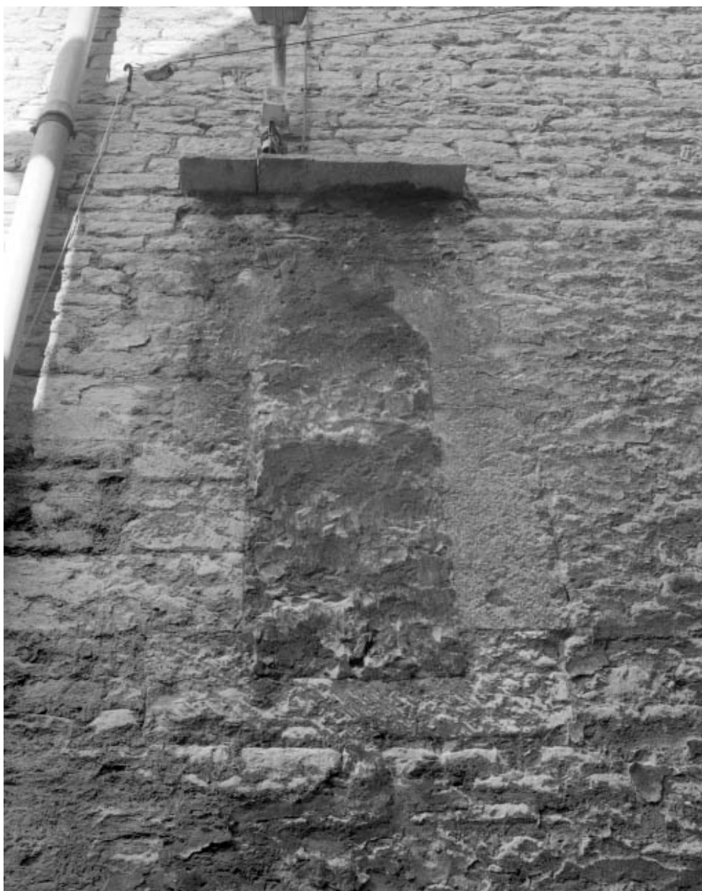
Façade latérale gauche : détail d'une baie murée.
