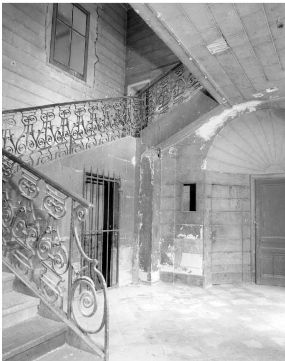
Intérieur : escalier d'honneur, vue d'ensemble en hauteur.
