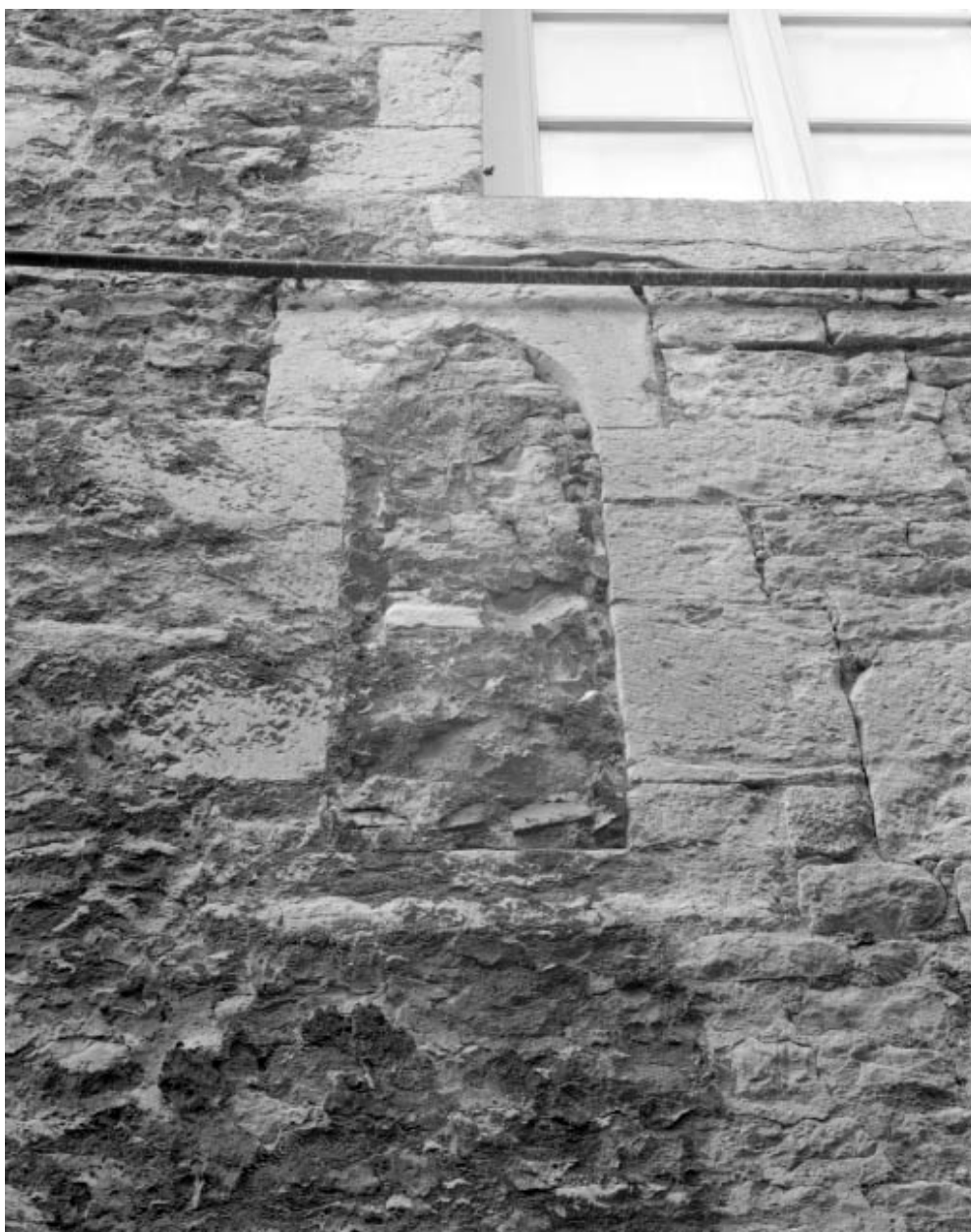
Façade latérale gauche : détail d'une baie murée.
