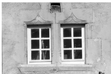
Maison : détail des fenêtres couvertes d'un arc en accolade. Phot. Laurent Poupard IVR43_19923901302Z
