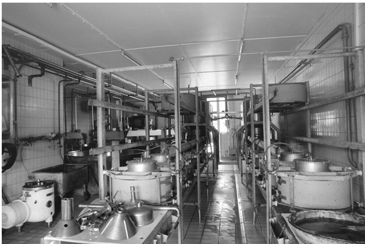
Intérieur de l'atelier de fabrication.
