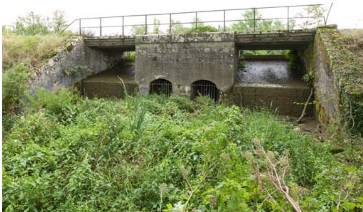
Vue du déversoir.
