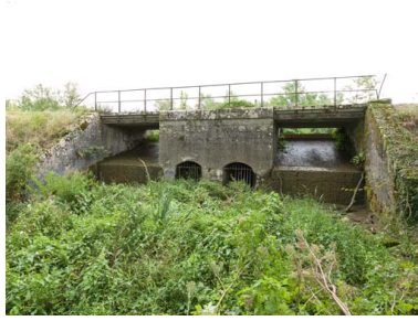
Vue du déversoir.
