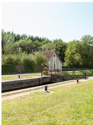
Vue du site d'écluse. Phot. Pierre-Marie Barbe-Richaud IVR26_20178900172NUC2A
