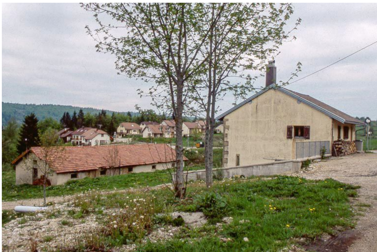
Façades antérieures et latérales droites de la fromagerie et de la porcherie.
