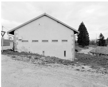
Façade droite de la fromagerie. Phot. Yves Sancey IVR43_19993900281X
