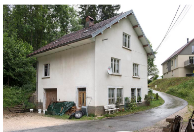
Façades sud est ouest. Phot. Sonia Dourlot IVR43_20172500580NUC4A
