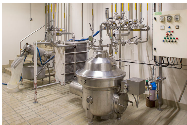
Salle de la station de lavage CIP : débourseuse (à droite) et filtre à serum. Phot. Sonia Dourlot IVR43_20142500758NUC2A
