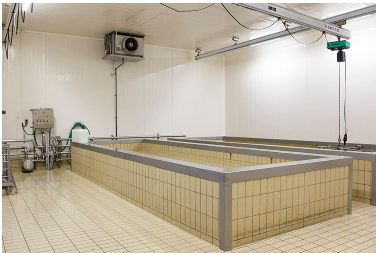
Atelier de saumurage : vue d'ensemble.
