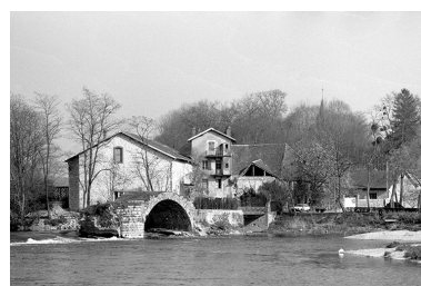
Façade antérieure. Phot. Laurent Poupard IVR43_19903901031Z
