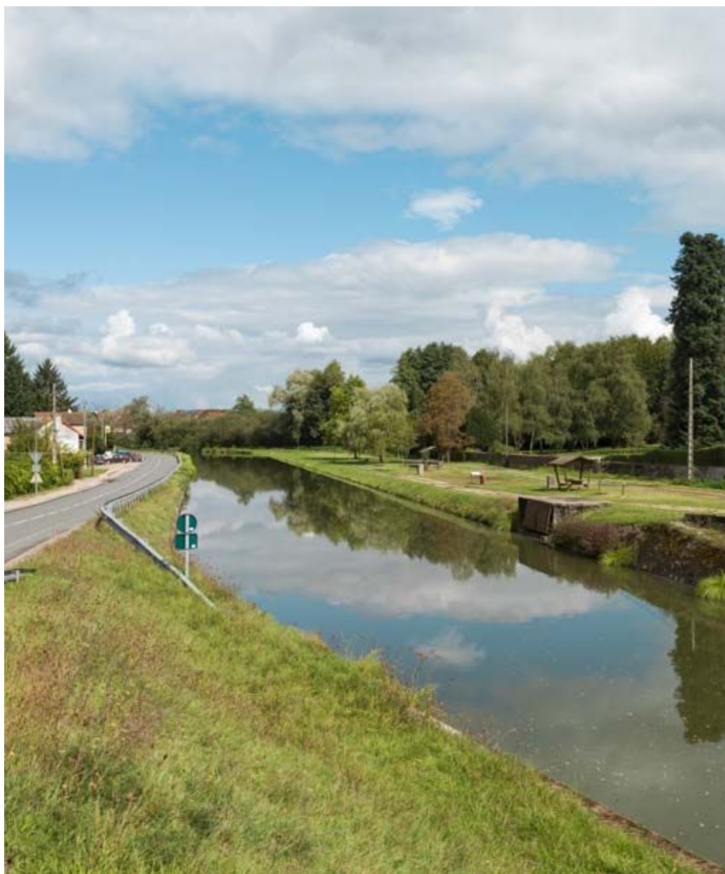
Vue d'ensemble du port.
