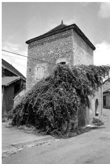
Vue du pigeonnier. Phot. Bernard Lardière IVR43_19817000509Z
