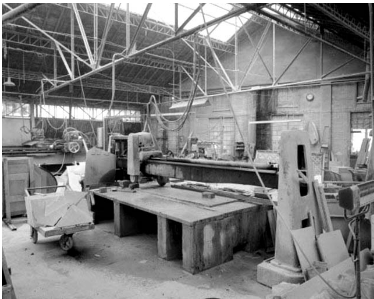
Débiteuse nord vue de l'arrière.
