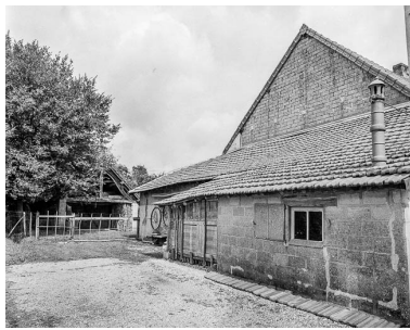
Face gauche. Phot. Dominique Dominguez IVR43_19773900054X
