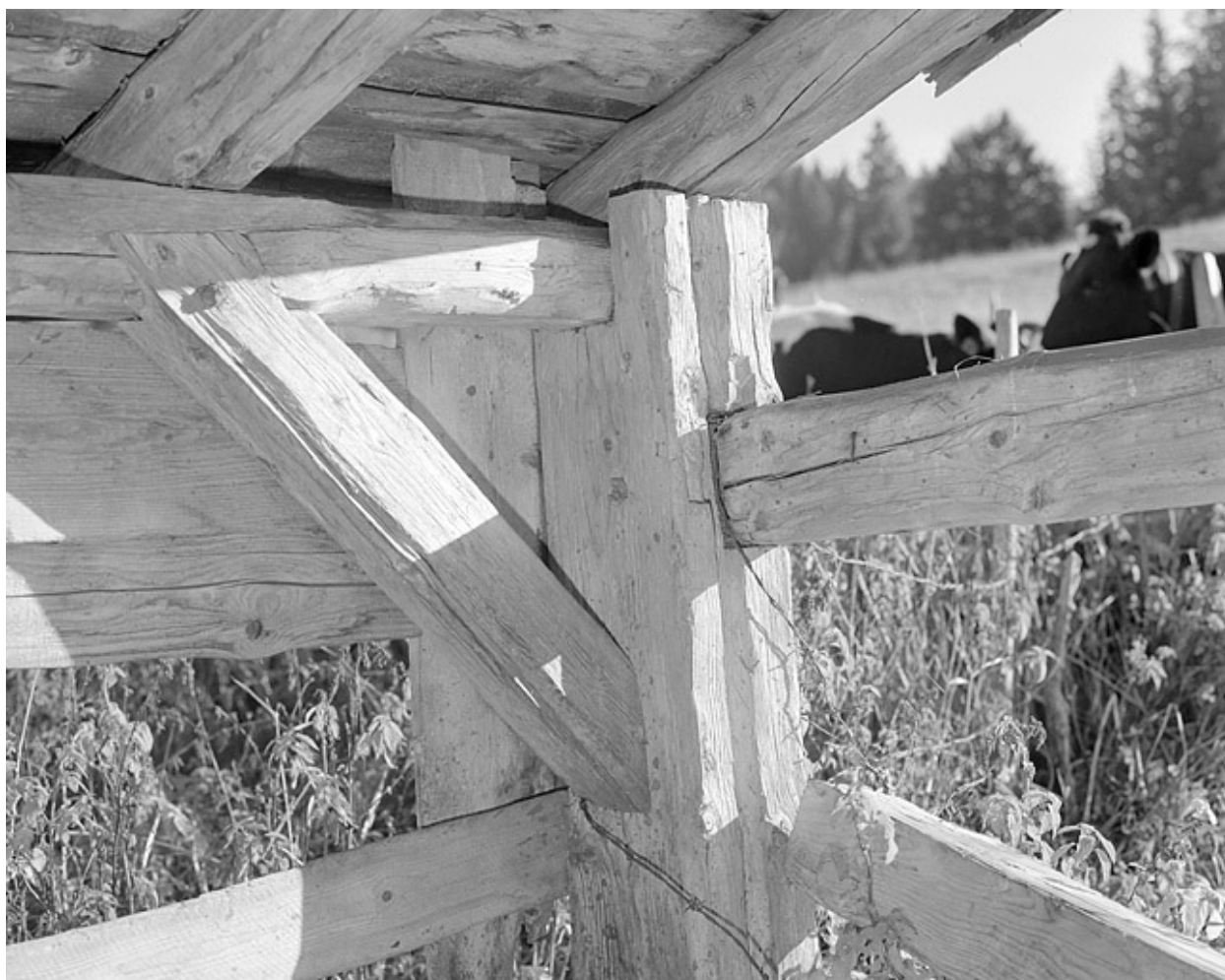
Assemblage de la charpente de l'abreuvoir.
