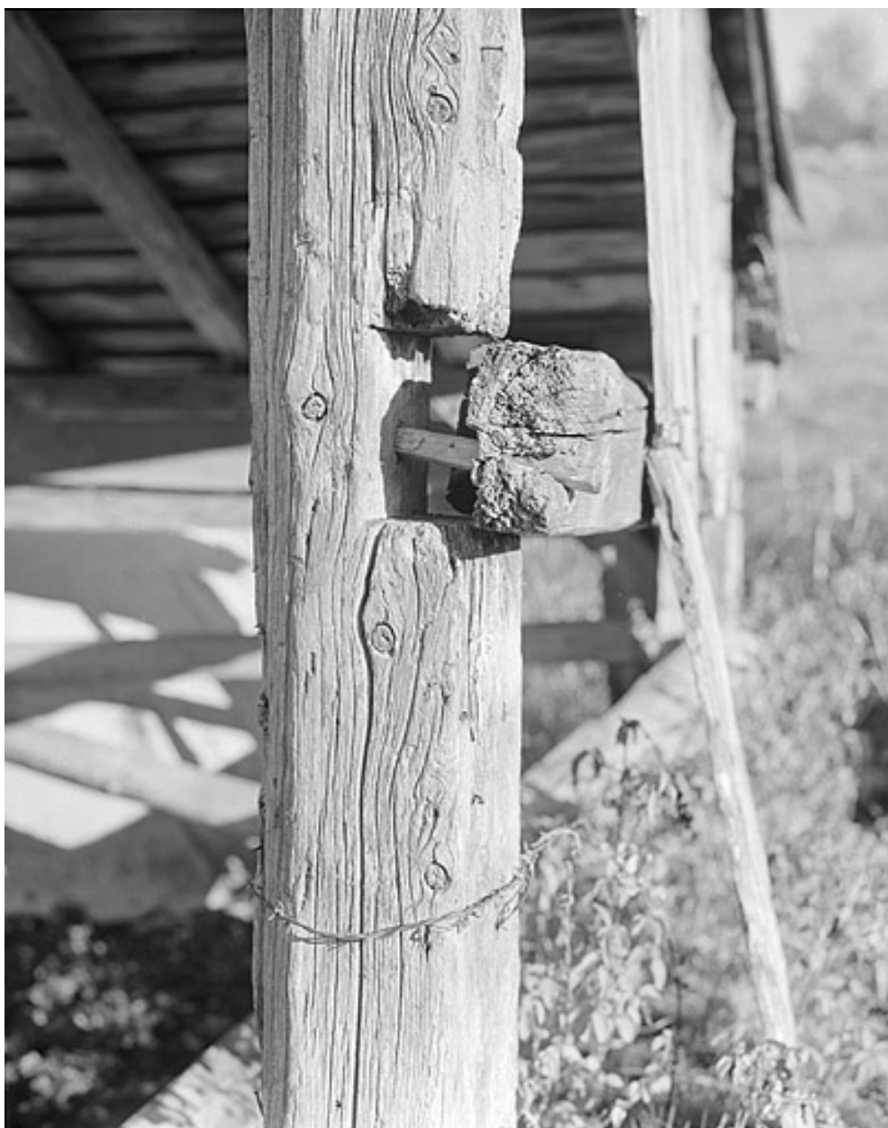
Assemblage à mi-bois poteaux-panne par une cheville.
