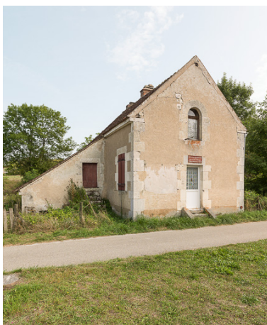
Vue de la maison éclusière.
