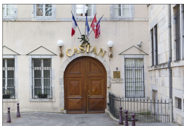
Vue du portail d'entrée sur rue.
