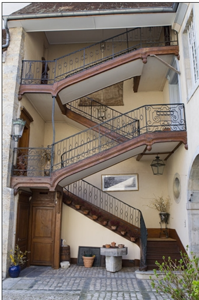
Vue d'ensemble de l'escalier à cage ouverte.
