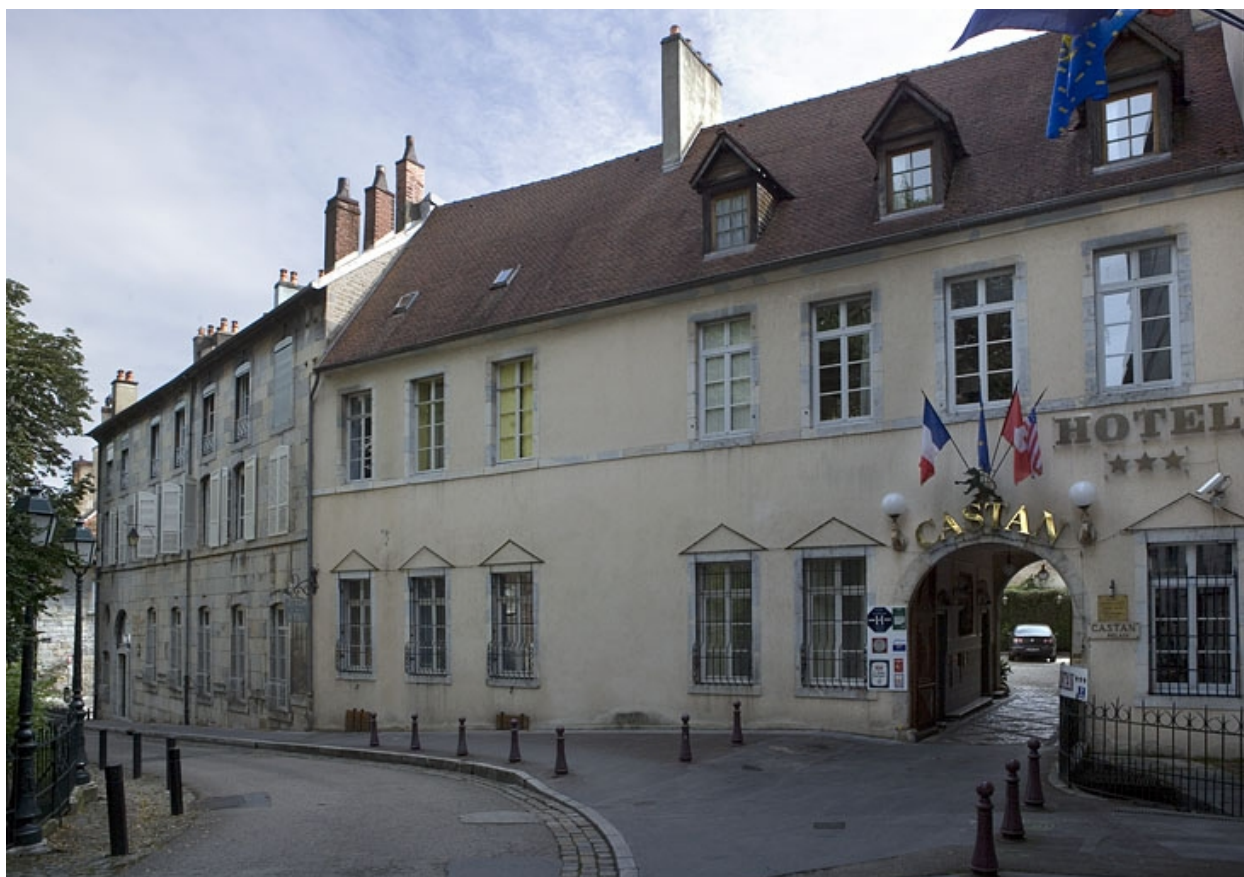
Vue d'ensemble depuis la rue.
