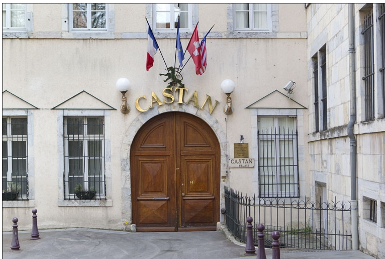
Vue du portail d'entrée sur rue.
