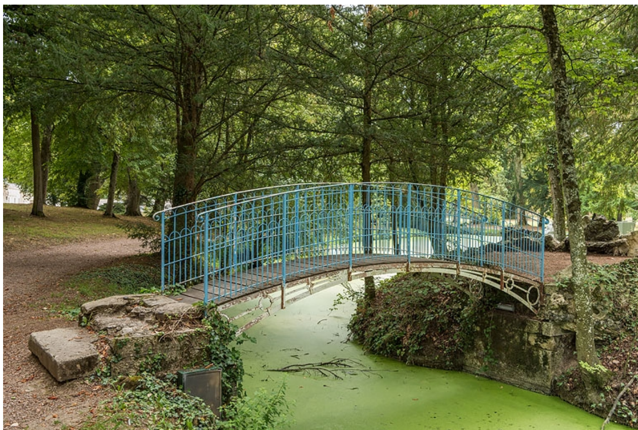
Passerelle métallique donnant accès à l'île.
