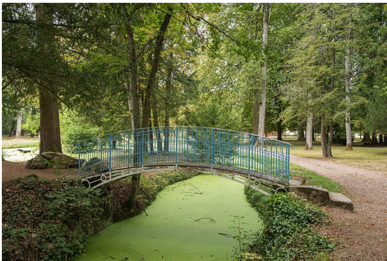
Passerelle métallique donnant accès à l'île.
