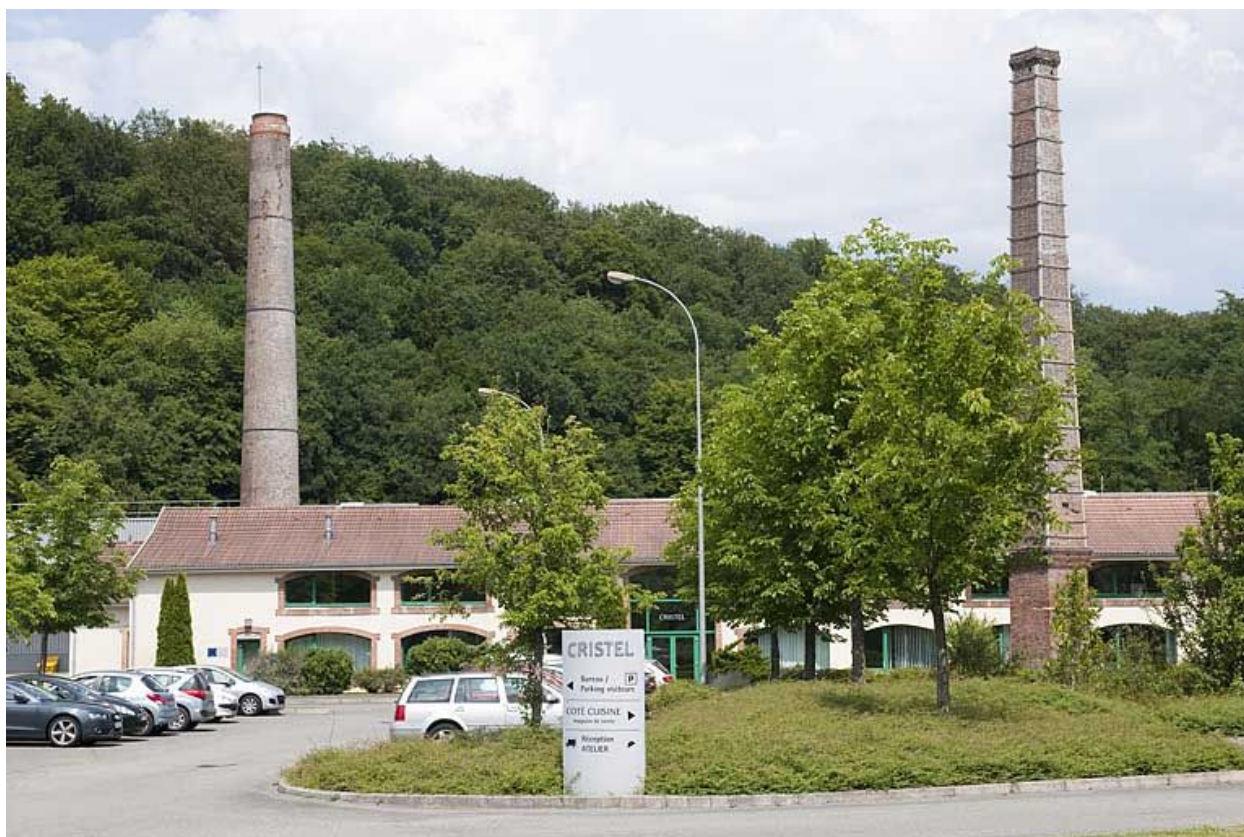
L'usine depuis l'entrée du site.
