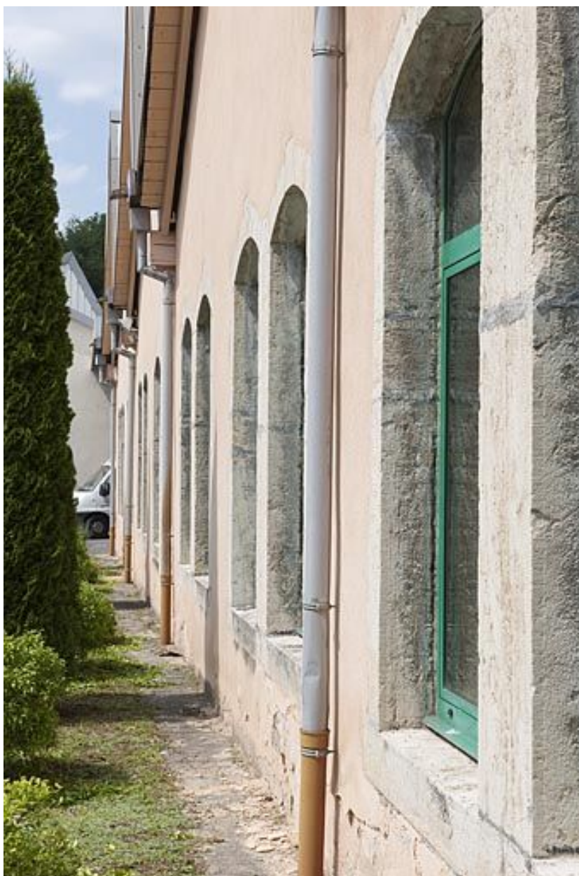
Façade ouest de l'atelier d'outillage.
