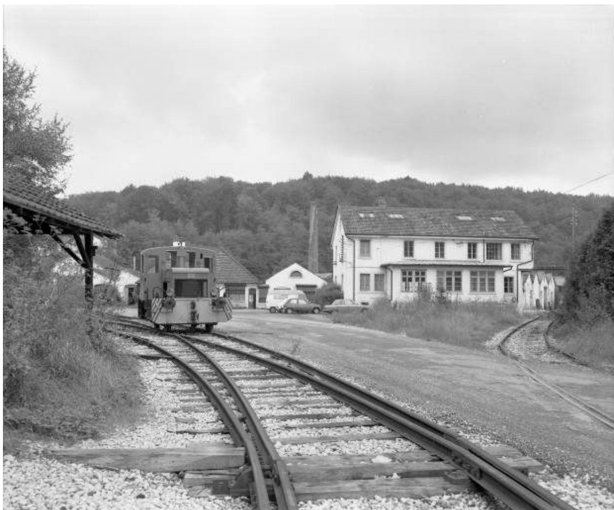
Vue d'ensemble depuis le sud-est en 1981.
