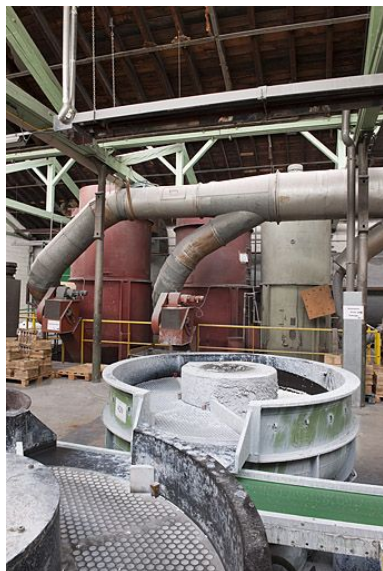
Atelier de polissage et chambre d'aspiration. Phot. Jérôme Mongreville IVR43_20112502322NUC4A
