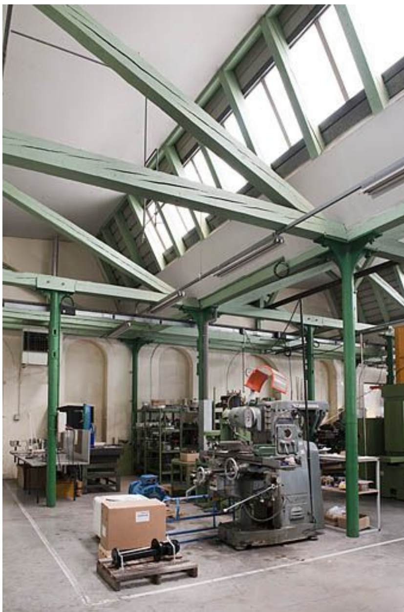
Atelier d'outillage. Détail de la charpente.
