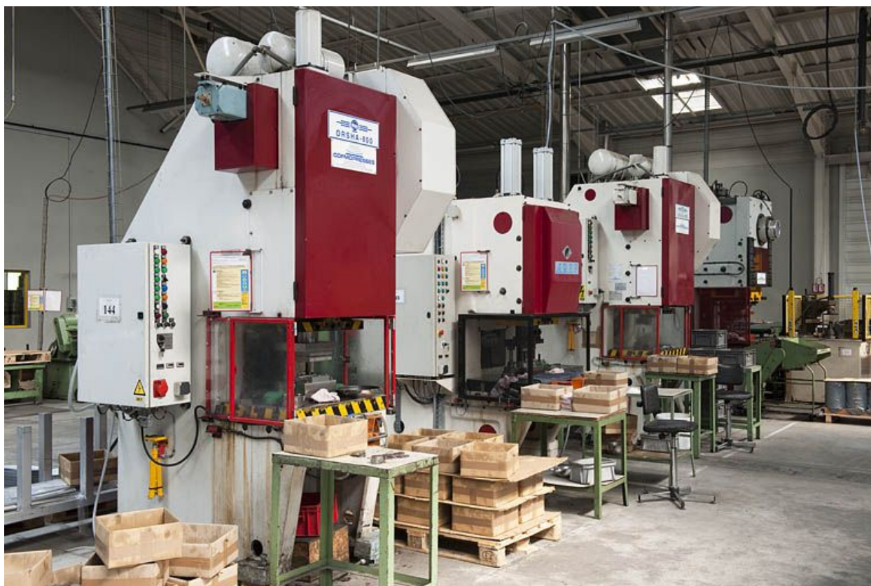
Atelier d'emboutissage. Batterie de presses.
