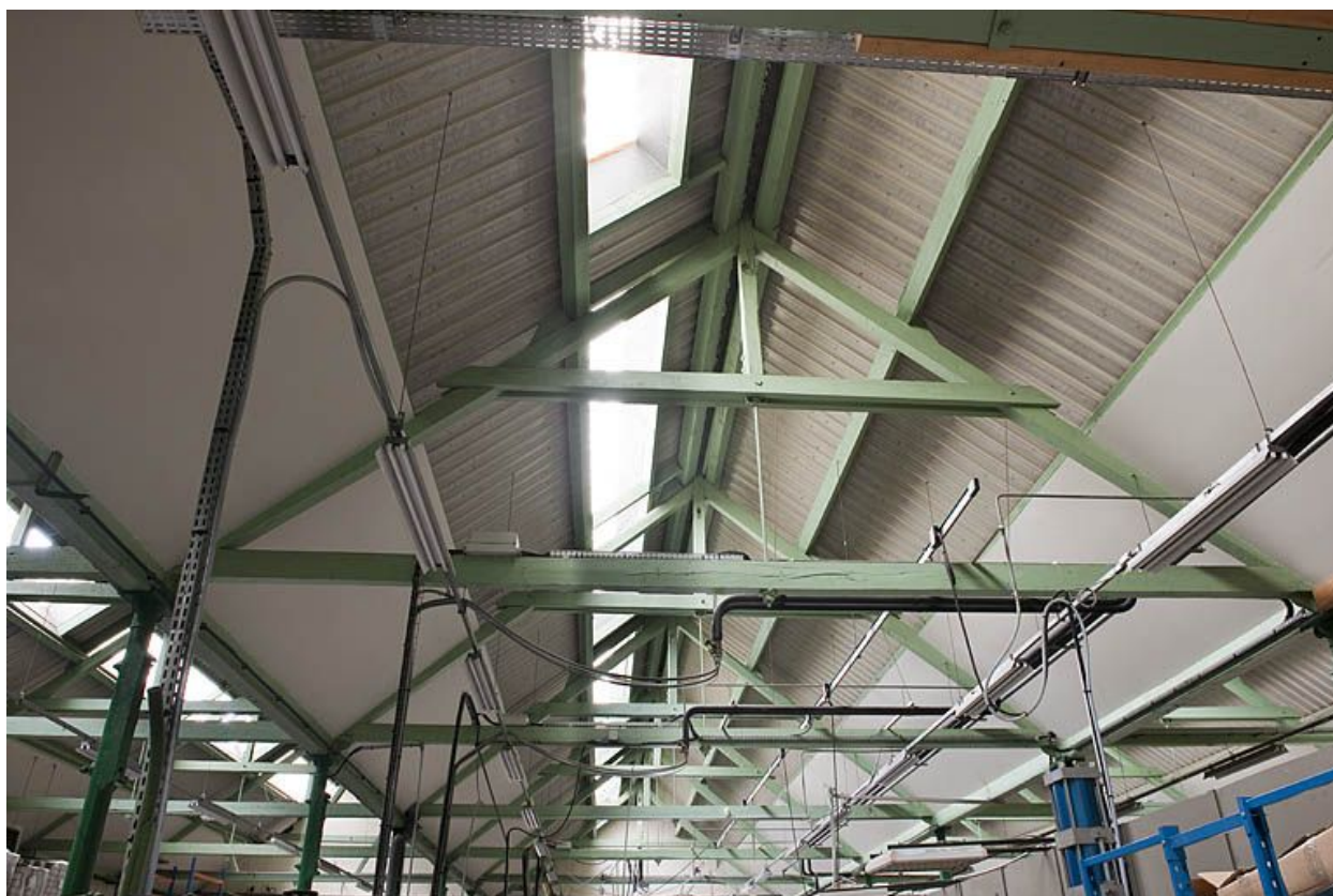
Charpente de l'atelier de finition.
