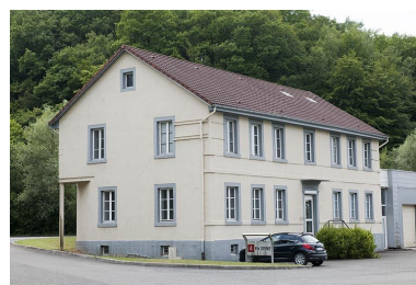
Ancien bâtiment des bureaux. Façade nord. Phot. Jérôme Mongreville IVR43_20112502304NUC4A
