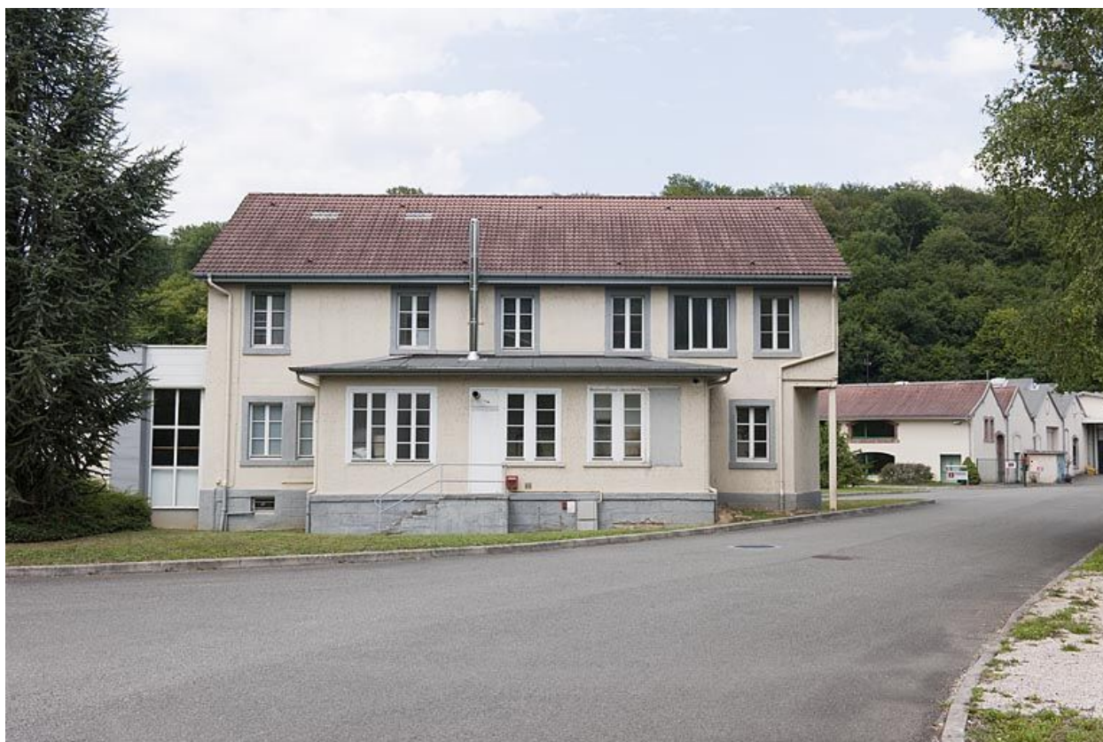
Ancien bâtiment des bureaux. Façade sud.
