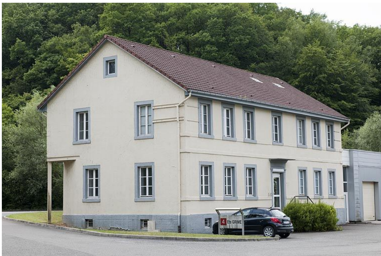
Ancien bâtiment des bureaux. Façade nord.
