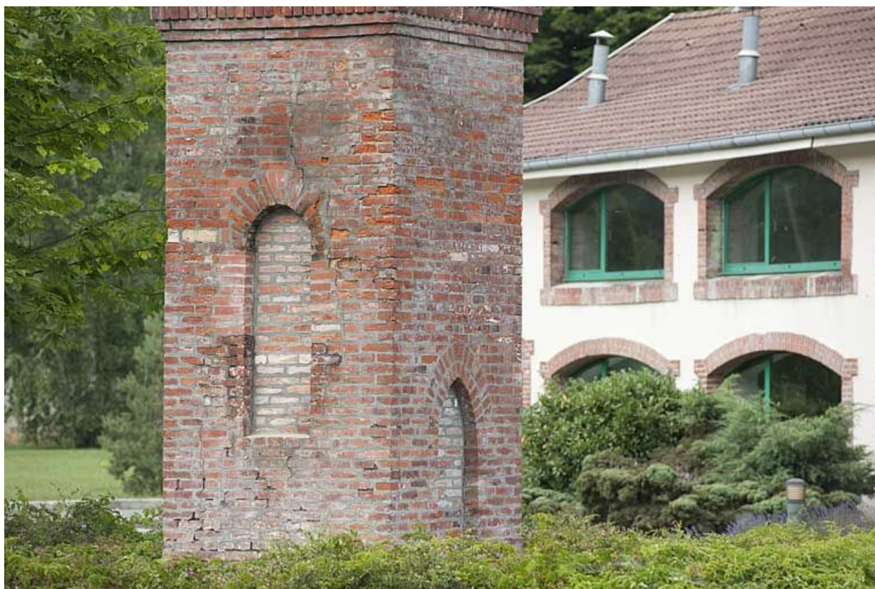
Soubassement de la cheminée carrée.
