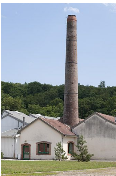
Cheminée et pignons nord des ateliers. Phot. Jérôme Mongreville IVR43_20112502296NUC4A
