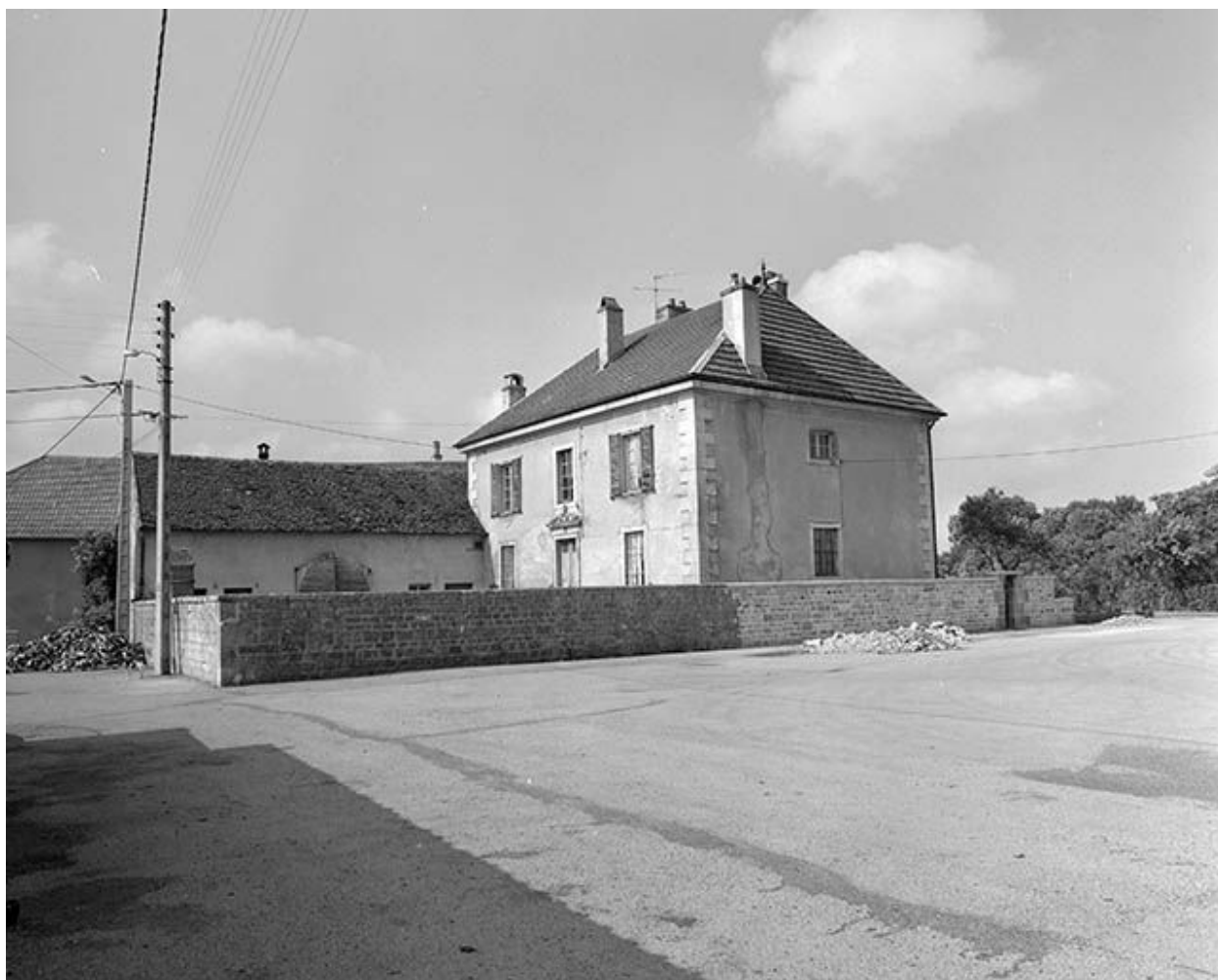
Façade antérieure et face latérale droite.
