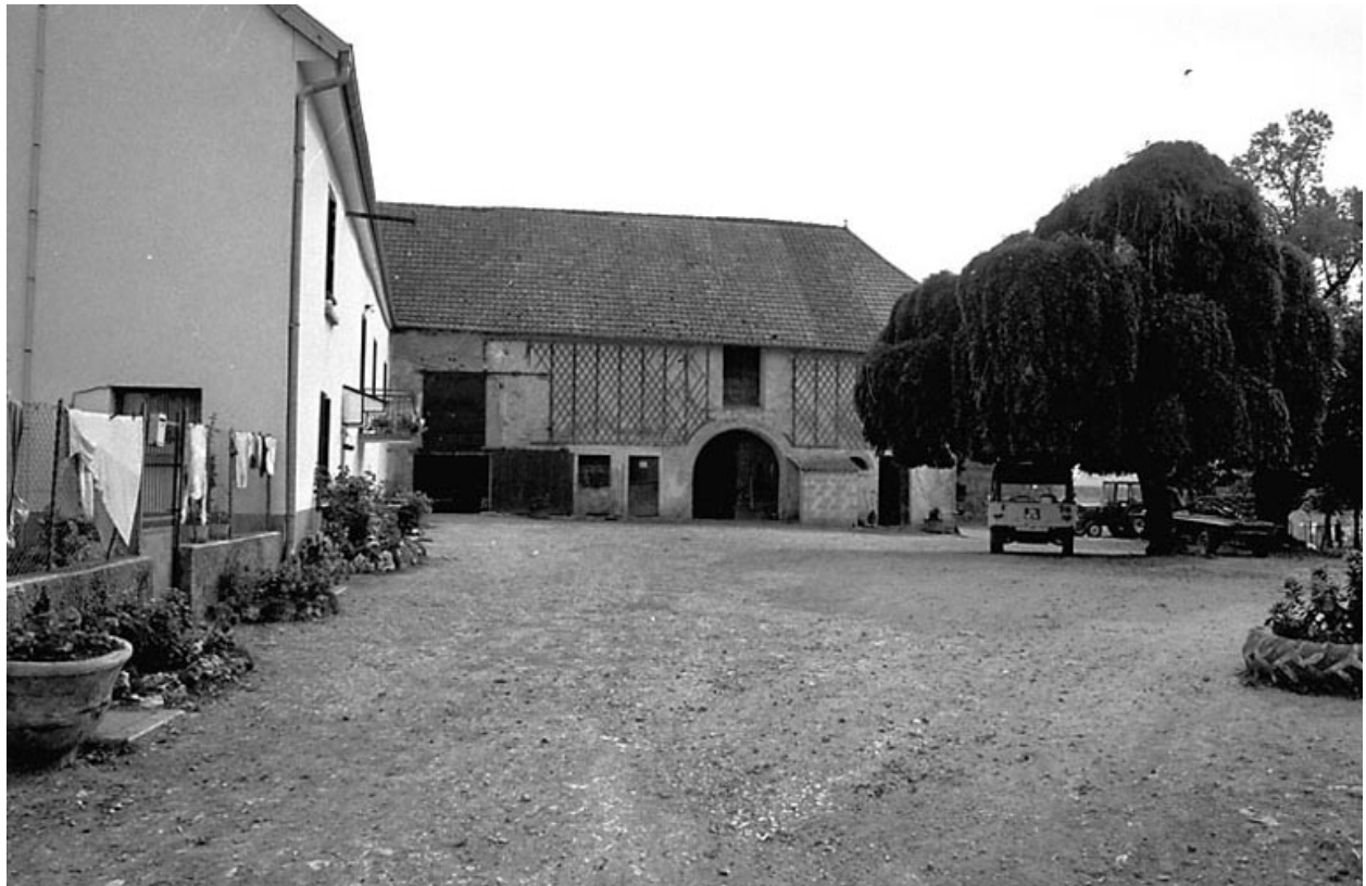
Façades sur cour.
