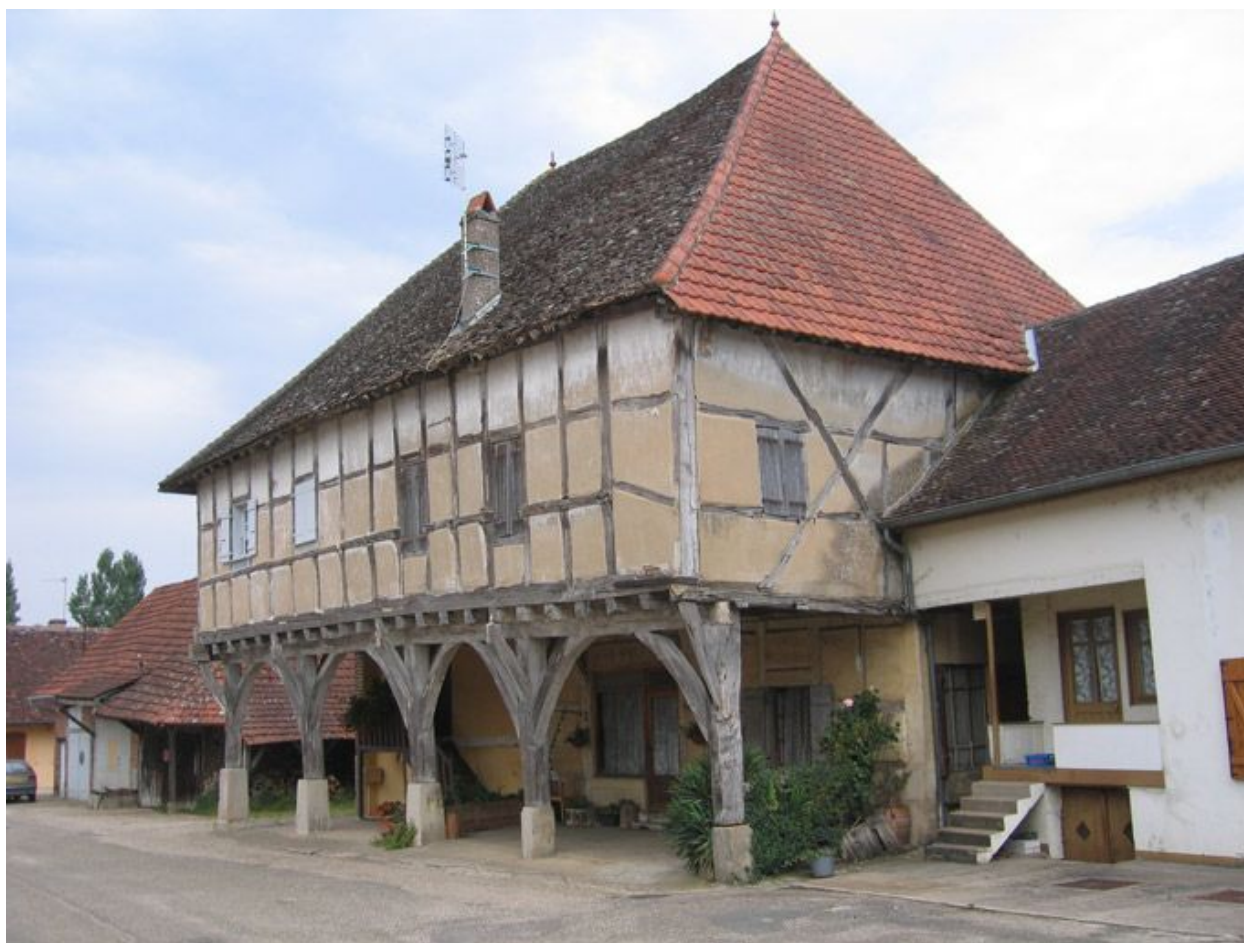
Vue d'ensemble de la façade.
