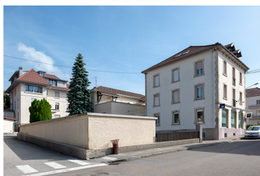
Vue d'ensemble depuis le sud- ouest (sur la rue Pasteur). Phot. Sonia Dourlot IVR43_20182500985NUC4A
