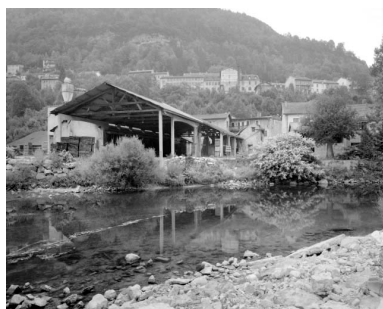
Magasins industriels depuis la rive droite de la Bienne. Phot. Jérôme Mongreville IVR43_19923900672X
