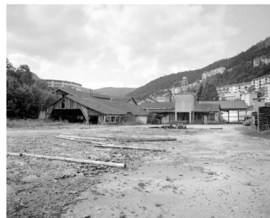
Ateliers de fabrication (scierie et ancienne diamanterie). Phot. Jérôme Mongreville IVR43_19923900670X
