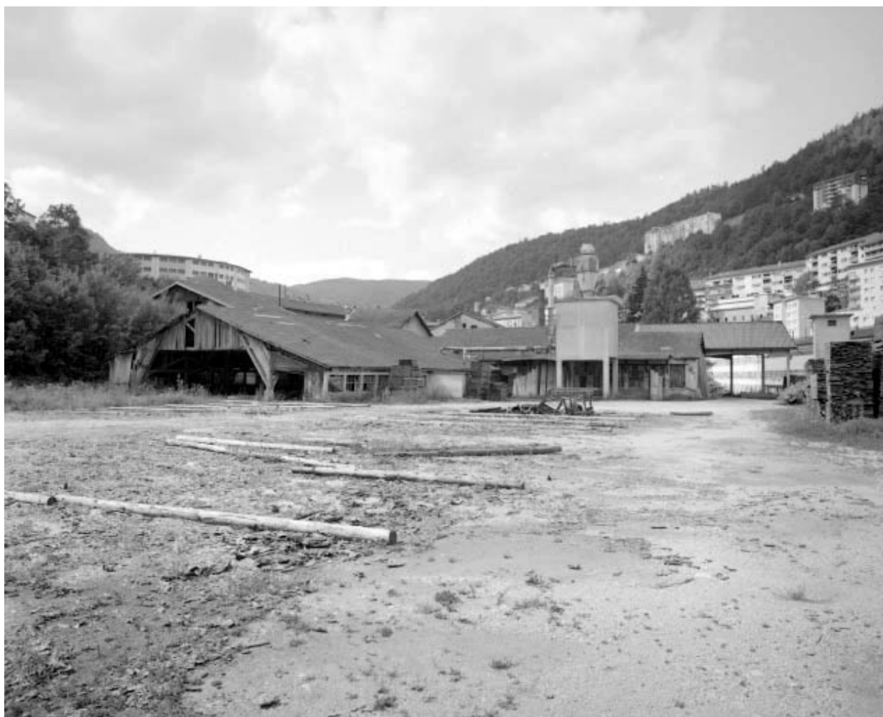
Ateliers de fabrication (scierie et ancienne diamanterie).
