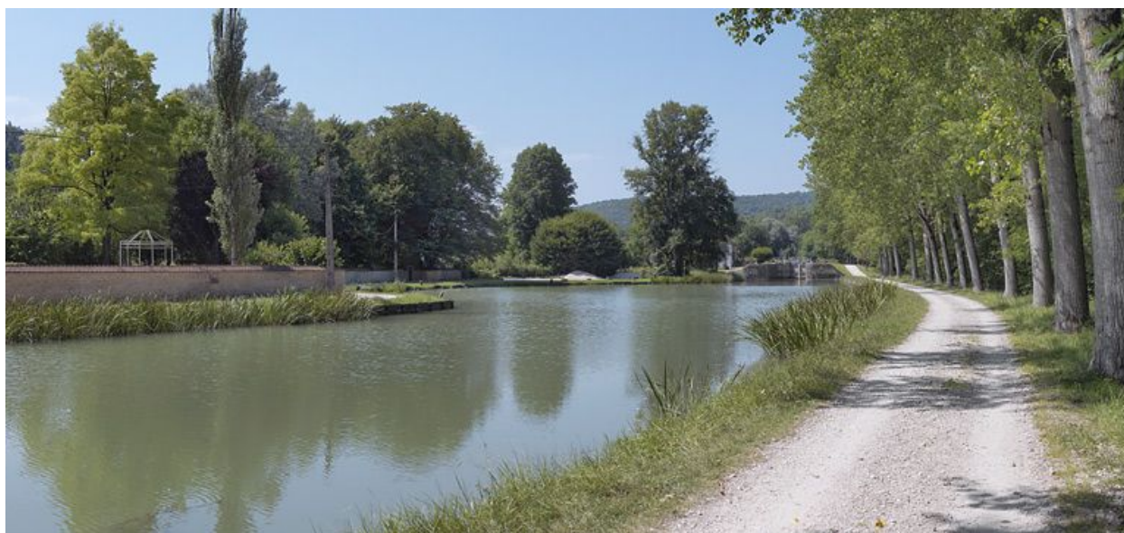
Le port vu d'aval.
