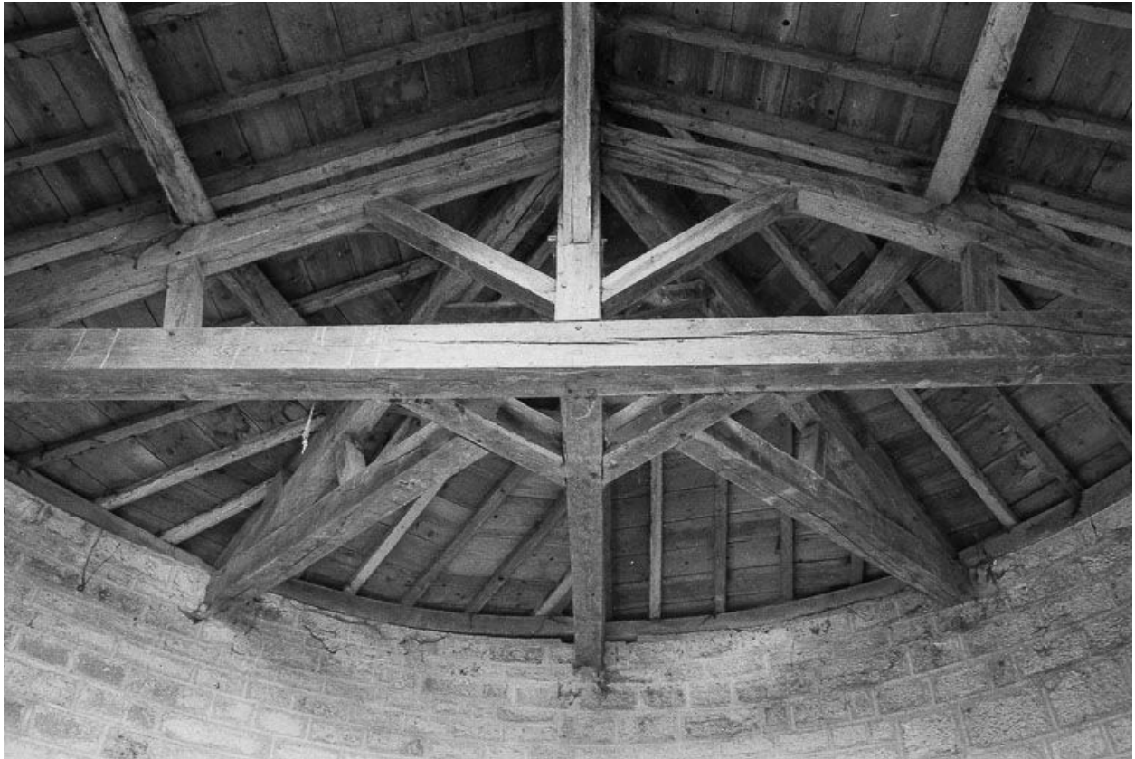
Détail de la charpente.
