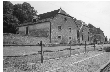
Façades sur rue. Phot. Bernard Lardière IVR43_19797000258Z
