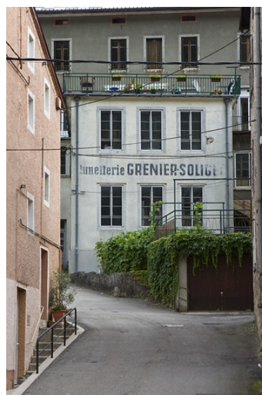
Usine Grenier-Soliget et Cie, Morez (10 avenue Charles de Gaulle) : façade sur la rue Fenandre. Phot. Yves Sancey IVR43_20103900539NUC2A
