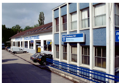
Usine Henry Jullien, Lons-le-Saunier (14 avenue Camille Prost). Phot. Jérôme Mongreville IVR43_19963900615ZA
