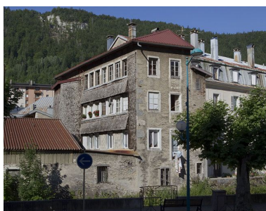
Atelier de lunetterie (actuellement immeuble), Morez (5 rue du Docteur Regad). Phot. Yves Sancey IVR43_20103900535NUC2A
