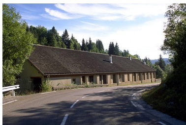
Usine de mécanique de précision puis de lunetterie Cottet puis de la Société des Lunetiers, Fonce-le-Bas.
