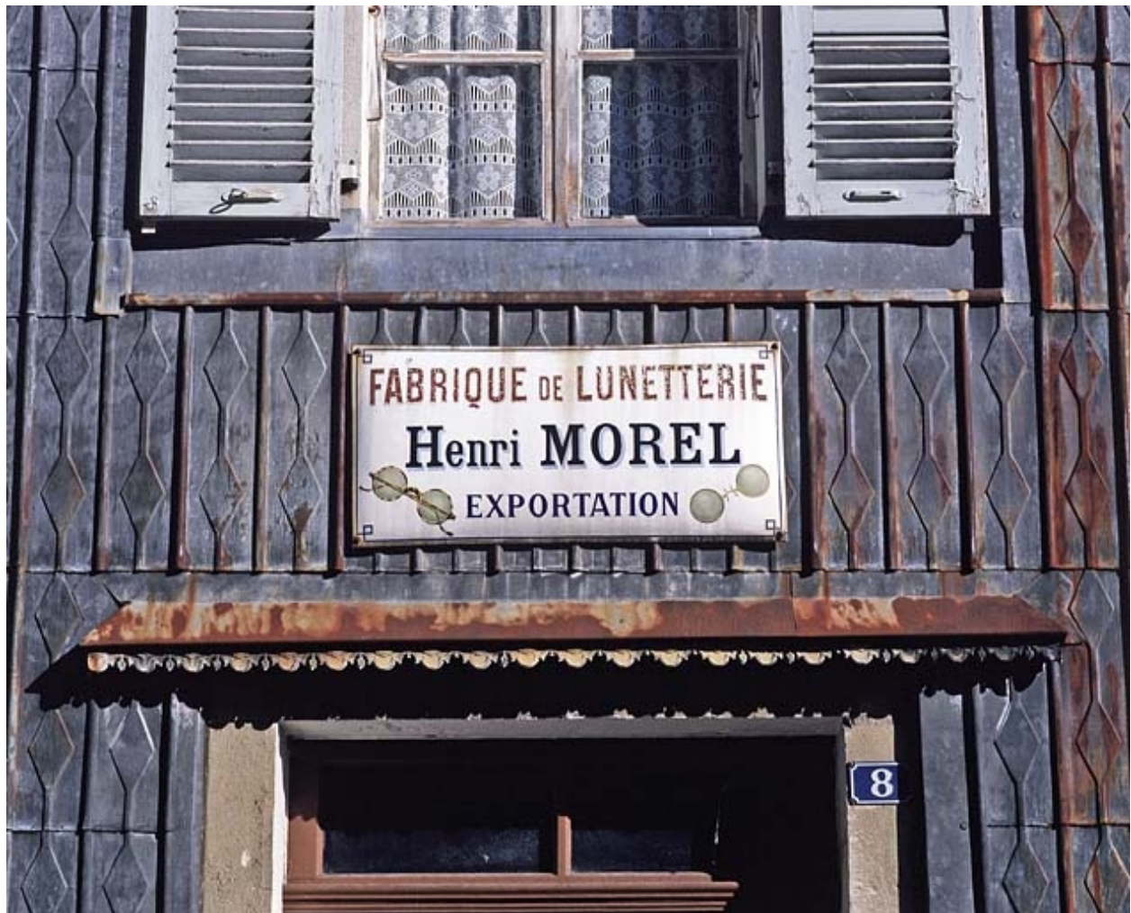
Tannerie puis usine de lunetterie, Morez (7-8 rue de la Tannerie).
