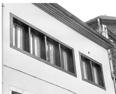
Hôtel et atelier de lunetterie, Morez (149 rue de la République) : fenêtres lunetières de l'aile sud.
