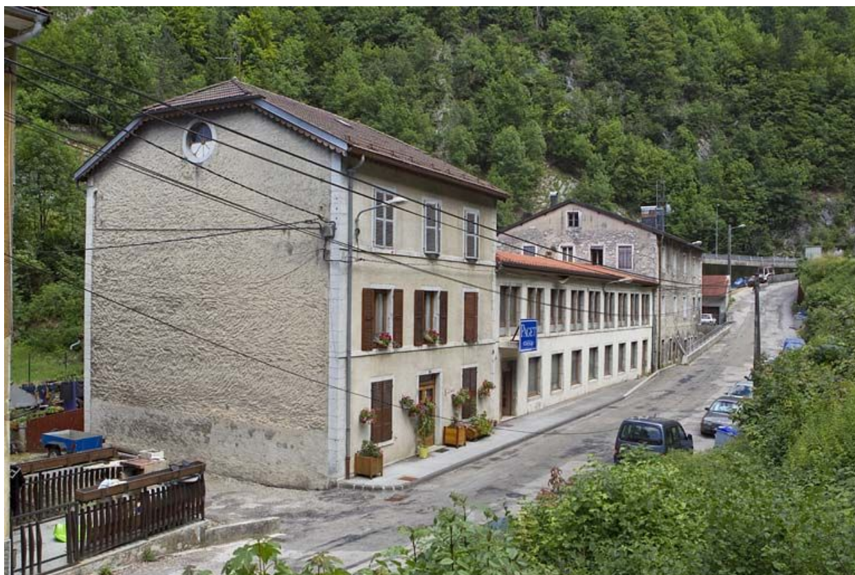
Usine de l'Abbaye, Morez (23-31 rue Emile Zola)
