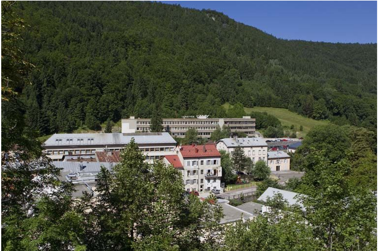
Usine Auguste Lamy Fils puis L'Amy, Morez (216-220 rue de la République et 11-13 rue Wladimir Gagneur) : site récent rue de la République.
