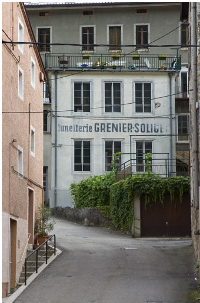
Usine Grenier-Soliget et Cie, Morez (10 avenue Charles de Gaulle) : façade sur la rue Fenandre.
