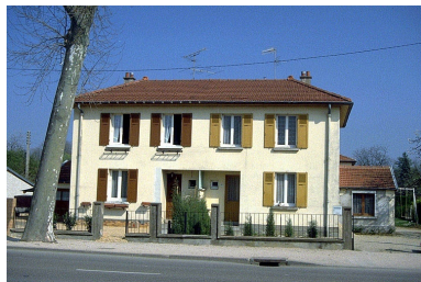
Façade antérieure. Phot. Laurent Poupard IVR43_19893900531ZA
