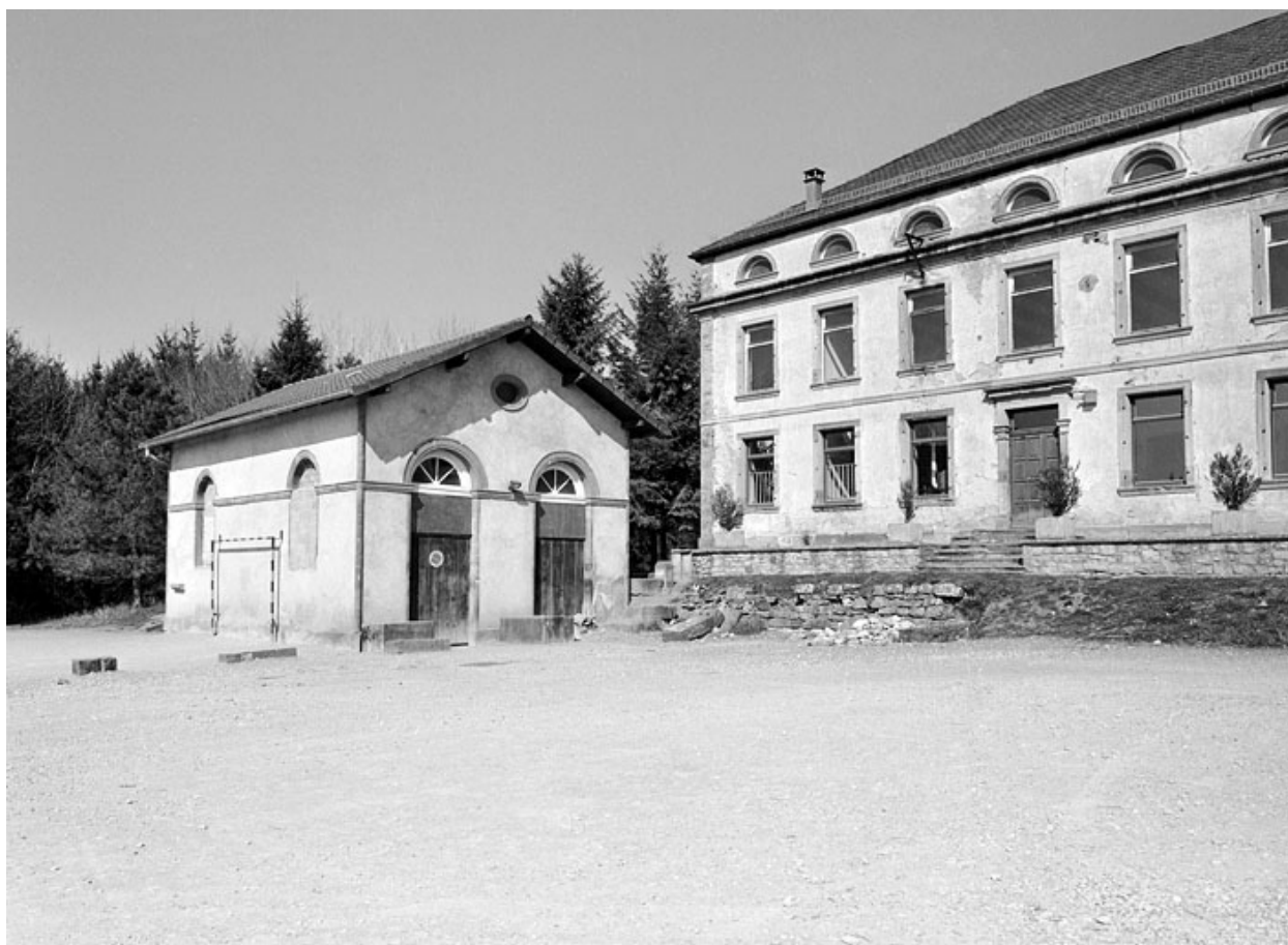
Salle des machines.
