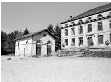
Salle des machines. Phot. Yves Sancey IVR43_20039000076X
