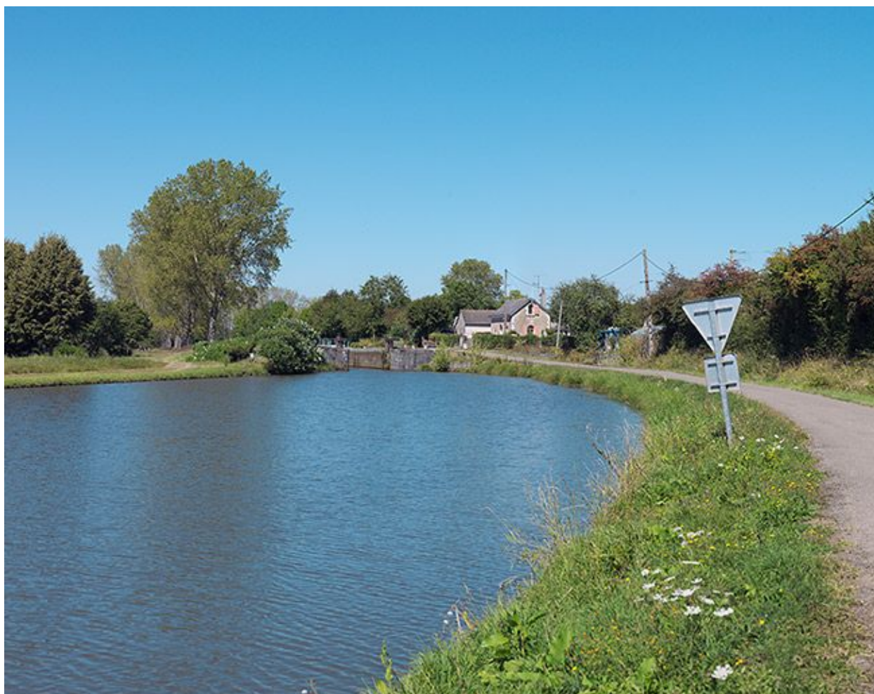
Vue d'ensemble du site prise d'aval.
