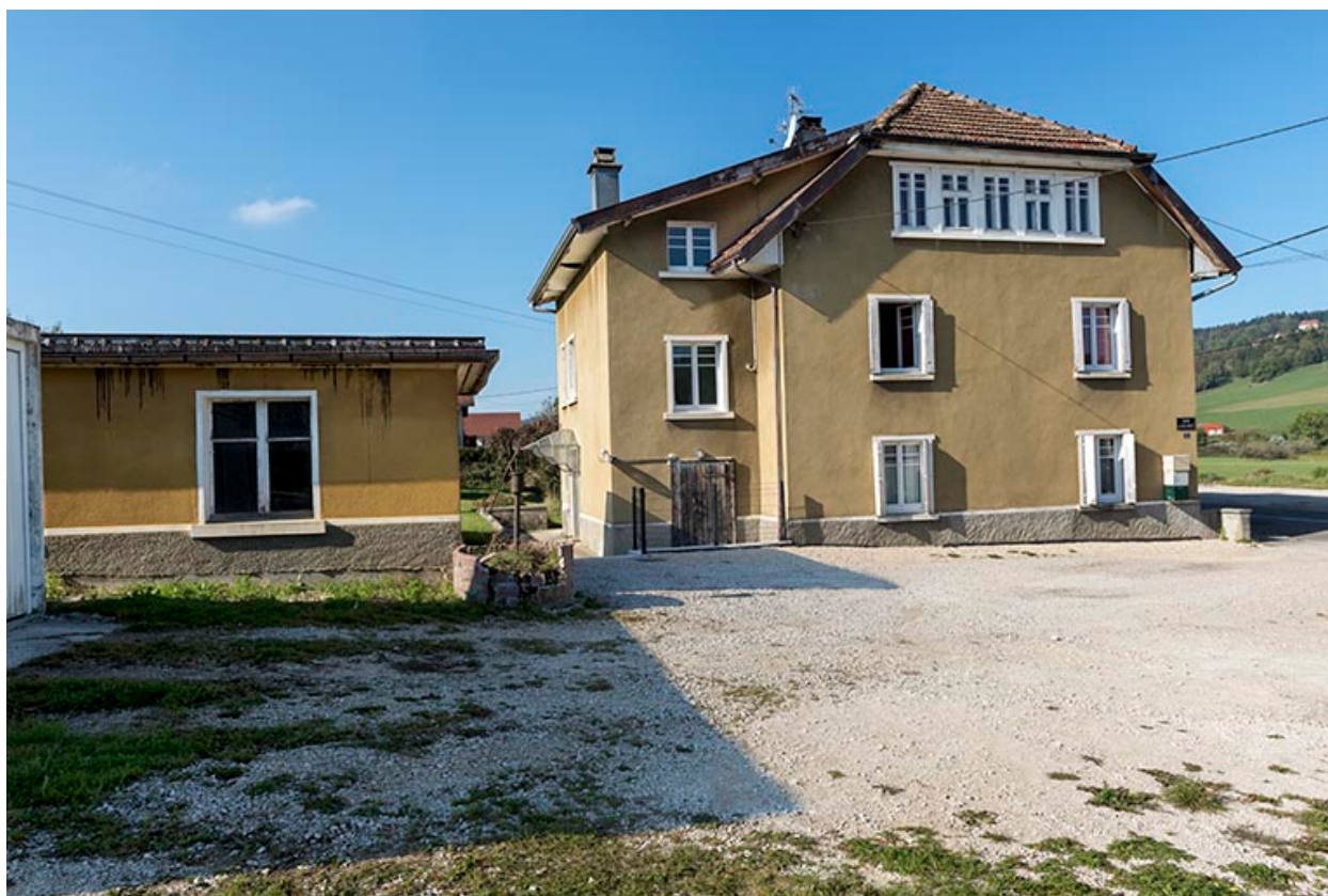
Garage et façade latérale gauche.
