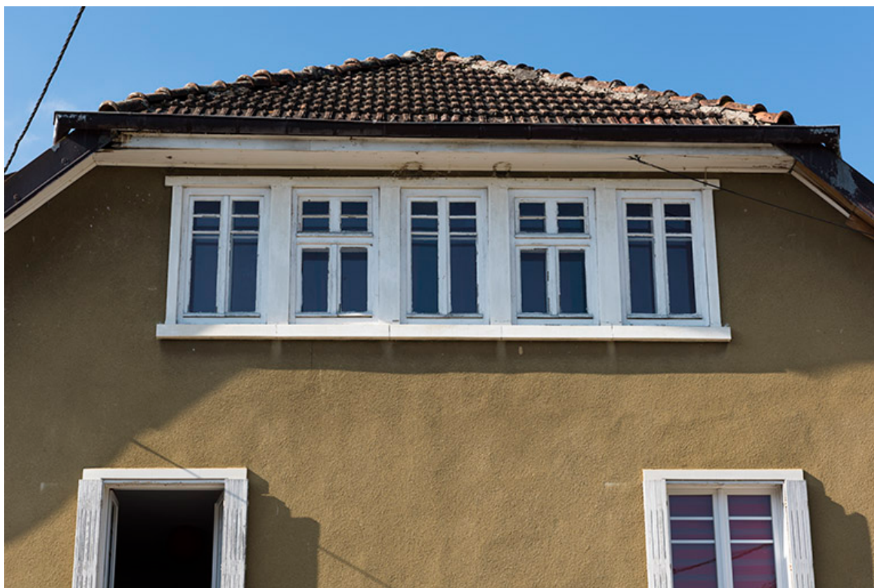
Façade latérale gauche : fenêtres multiples.
