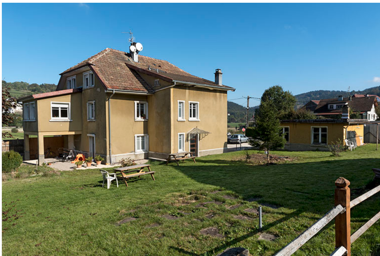
Façades postérieure et latérale droite.
