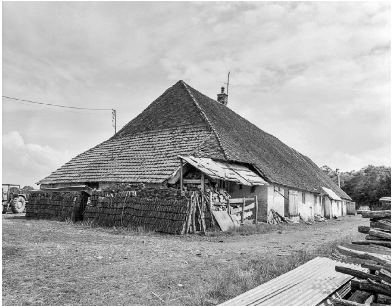
Façade postérieure et face droite.
