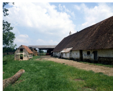
Façade postérieure. Phot. Yves Sancey IVR43_19903901172XA
