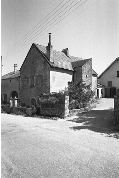
Vue d'ensemble. Phot. Bernard Lardière IVR43_19817000140Z
