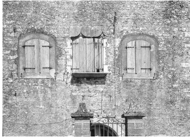
Mur en moellons calcaires recouverts d'enduit Phot. Bernard Lardière IVR43_19817000141Z
