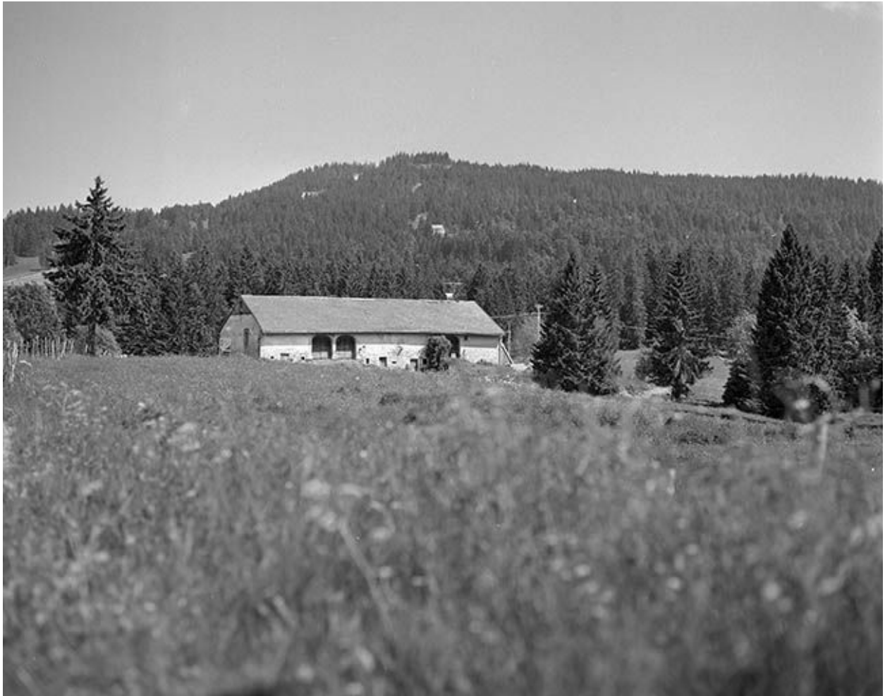
Vue éloignée de la façade postérieure.
