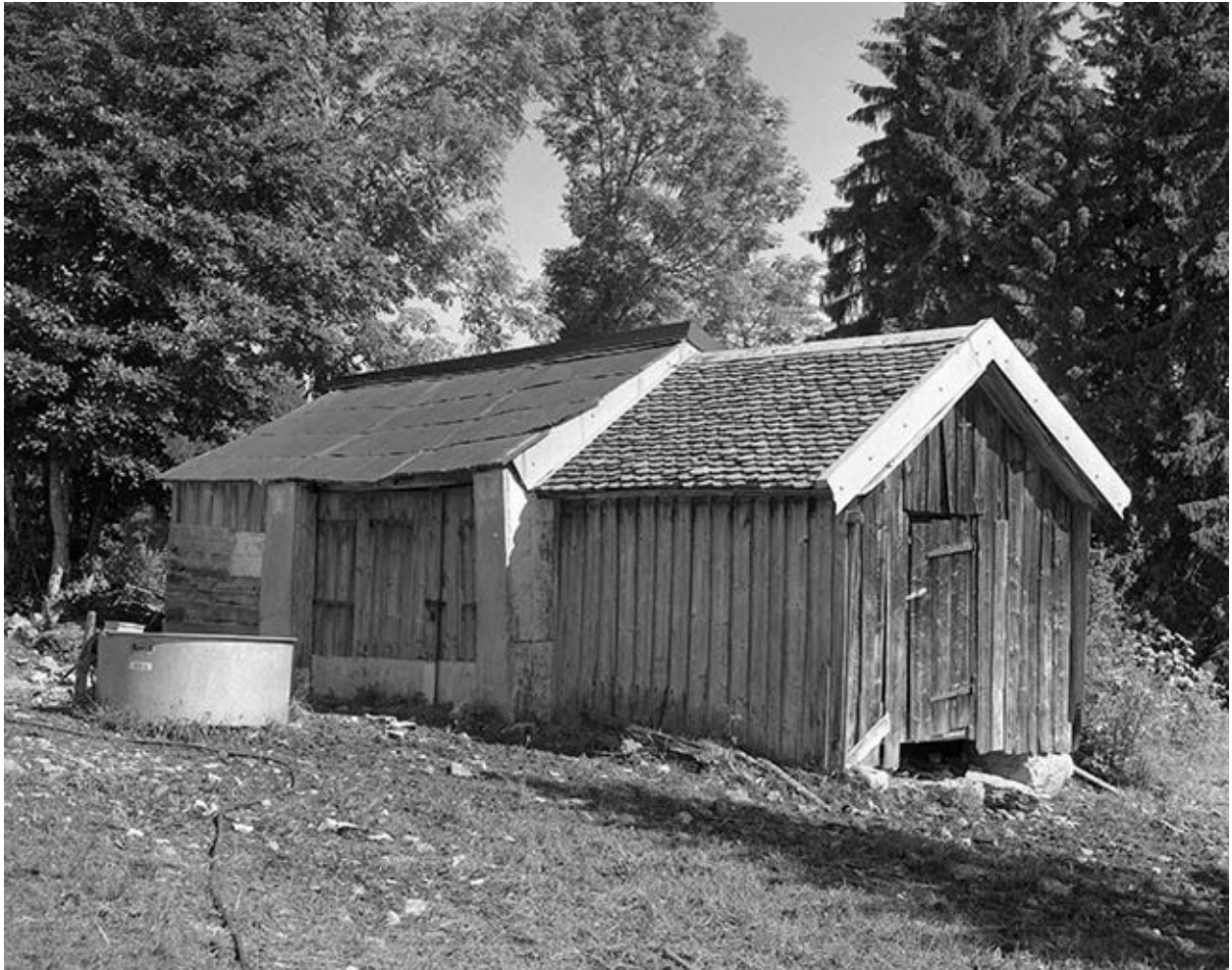
Resserre appelée " grenier fort ".
