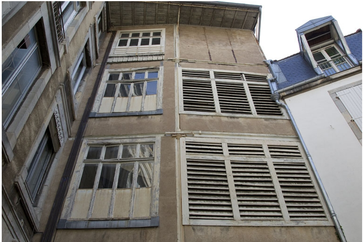
Escalier à gauche de la cour : détail de la cage.
