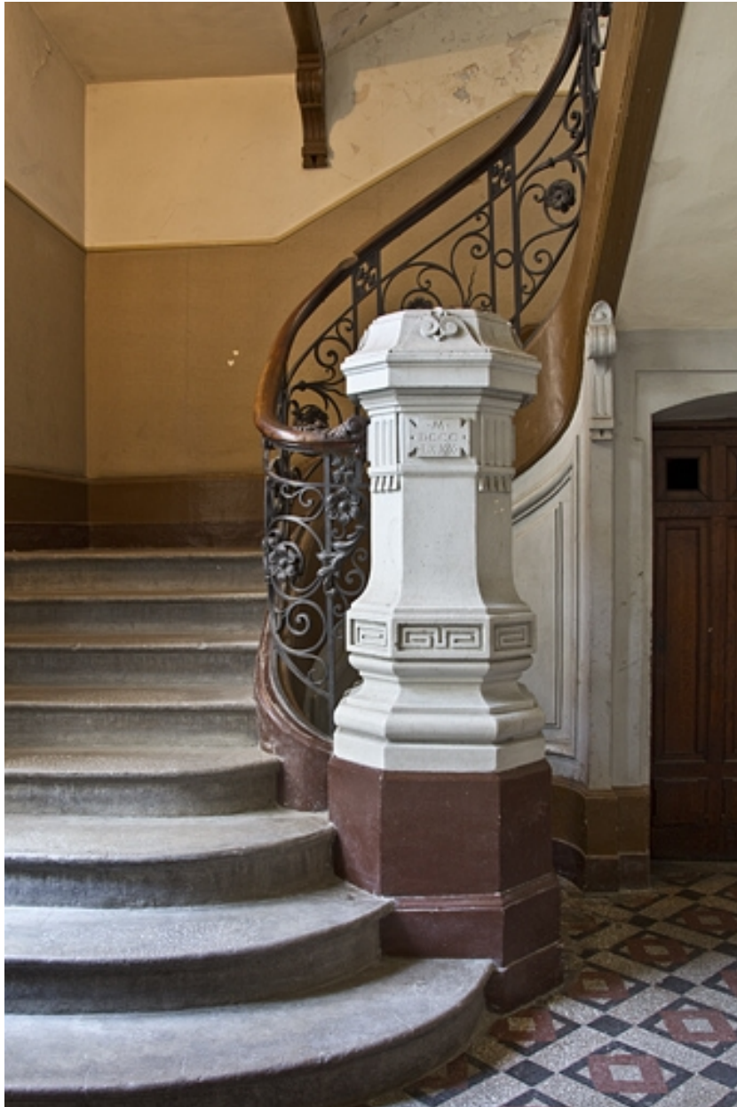
Logis principal, départ de l'escalier dans oeuvre.
