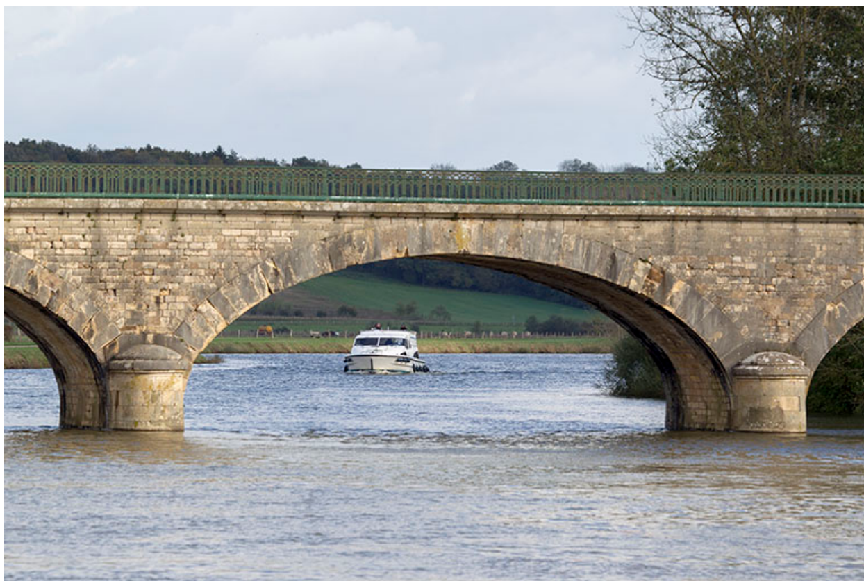
Détail d'une arche maçonnée du pont.
