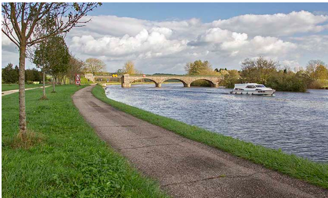
Vue depuis l'aval.
