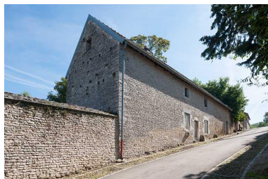
Vue générale nord-ouest Phot. Jérôme Mongreville IVR43_20137000353NUCA
