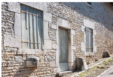
Baies de la façade ouest Phot. Jérôme Mongreville IVR43_20137000351NUCA
