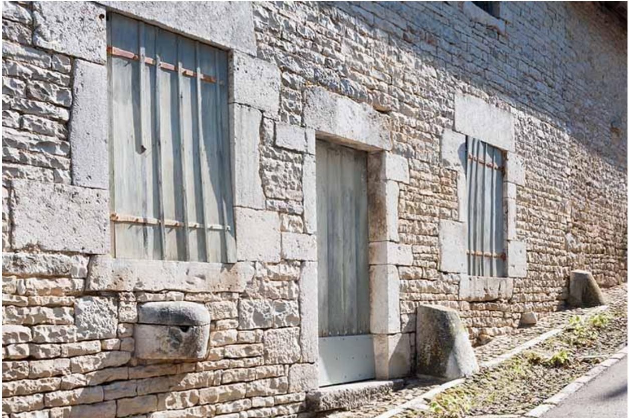
Baies de la façade ouest
