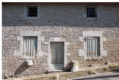
Façade ouest Phot. Jérôme Mongreville IVR43_20137000352NUCA
