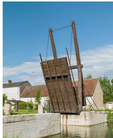
Vue du tablier en bois pendant le levage. Phot. Pierre-Marie Barbe-Richaud IVR26_20135800438NUC4AQ
