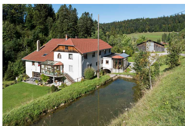
Derrière le Mont : moulin et scierie Chardon. La Douve coule à gauche, le bassin de retenue est au premier plan. Phot. Sonia Dourlot IVR43_20172501773NUC4A
