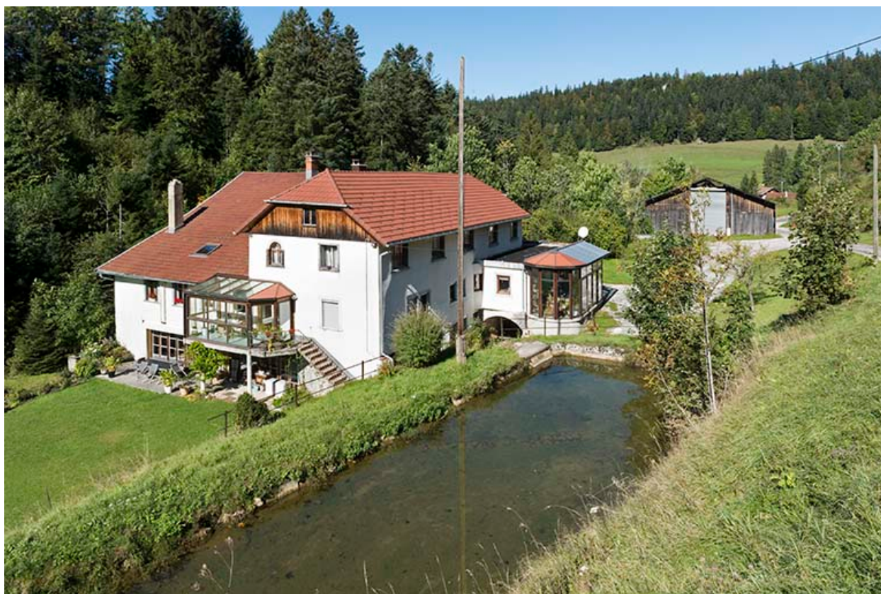
Derrière le Mont : moulin et scierie Chardon. La Douve coule à gauche, le bassin de retenue est au premier plan.
