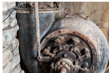
Cornabey : moulin et scierie Chopard puis Porterat, puis scierie Gaiffe. Turbine Douge, Besançon. Phot. Sonia Dourlot IVR43_20172501700NUC4A
