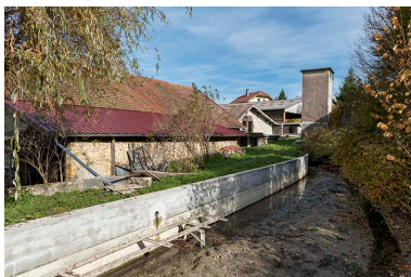
Cornabey : moulin et scierie Chopard puis Porterat, puis scierie Gaiffe. Canal d'amenée. Phot. Sonia Dourlot IVR43_20172501668NUC4A
