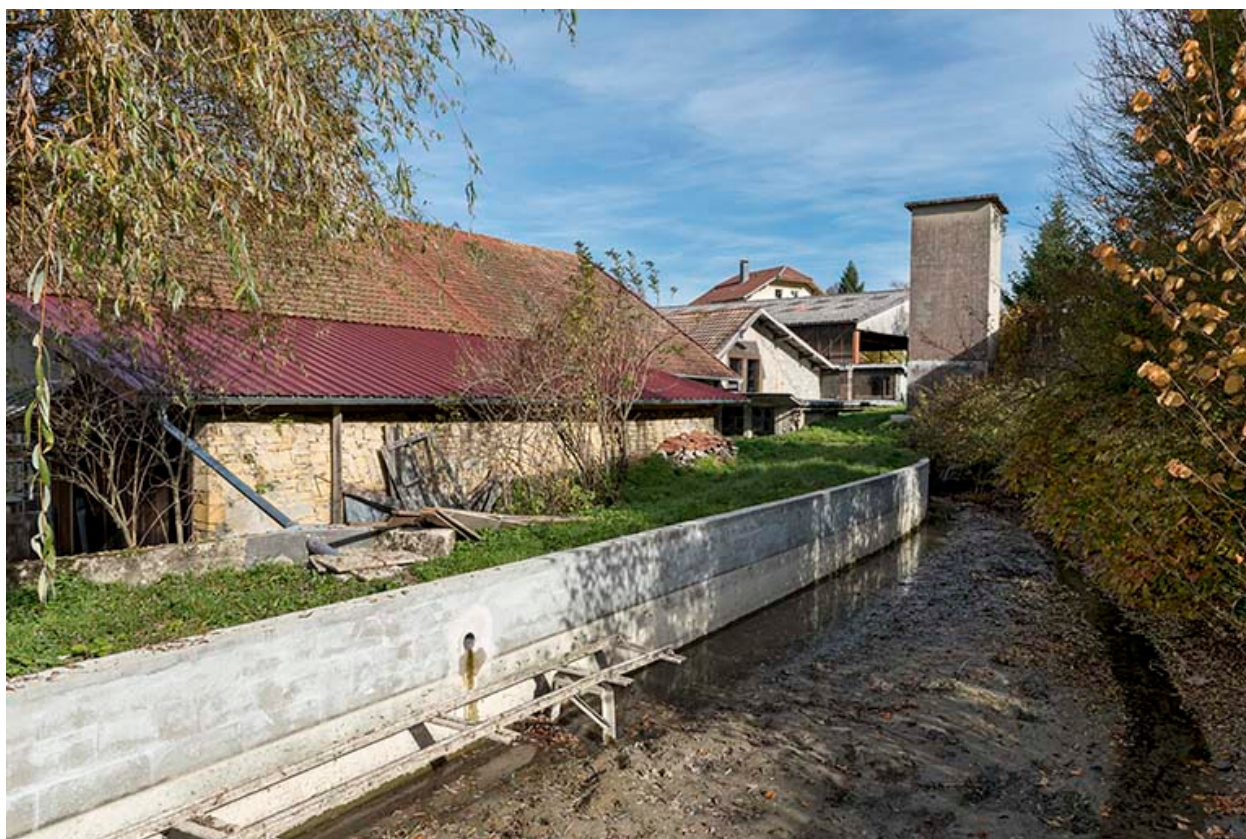
Cornabey : moulin et scierie Chopard puis Porterat, puis scierie Gaiffe. Canal d'aménée.
