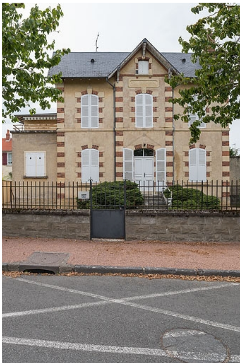
Vue de face, depuis l'avenue du Casino.
