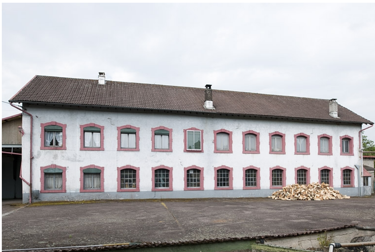
Atelier de fabrication. Façade antérieure.
