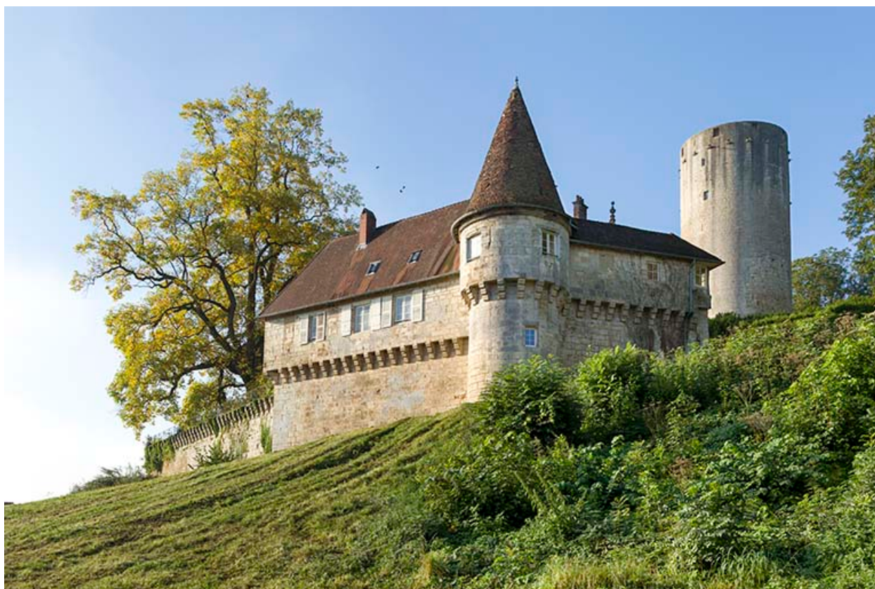
Vue générale depuis le nord.
