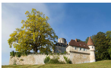
Vue générale nord-est. Phot. Sonia Dourlot IVR43_20167000825NUC2A
