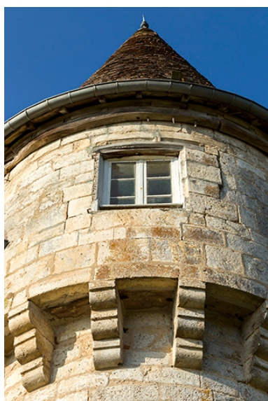
Détail : la tourelle. Phot. Sonia Dourlot IVR43_20167000827NUC2A
