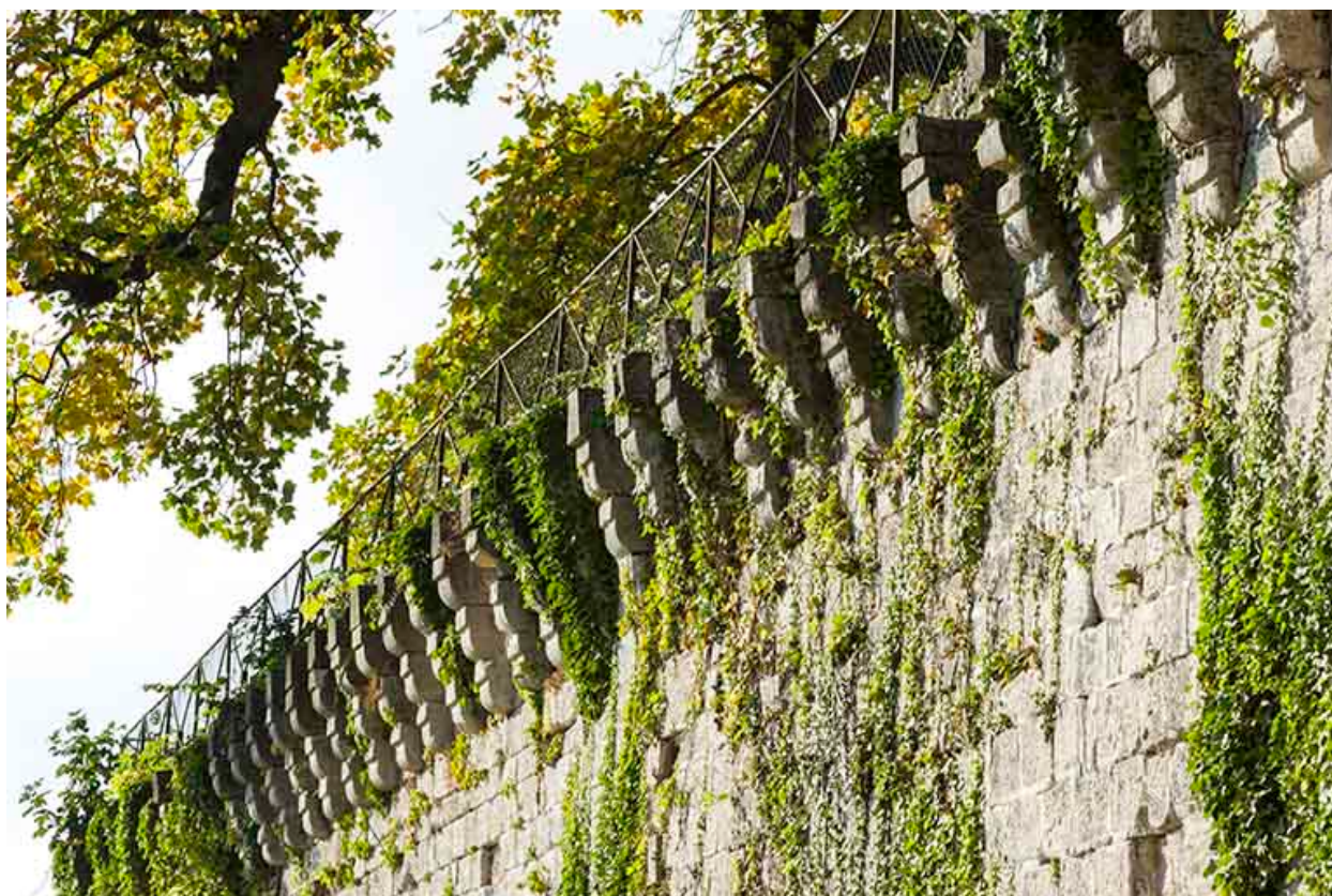
Détail de l'enceinte, au nord-est.
