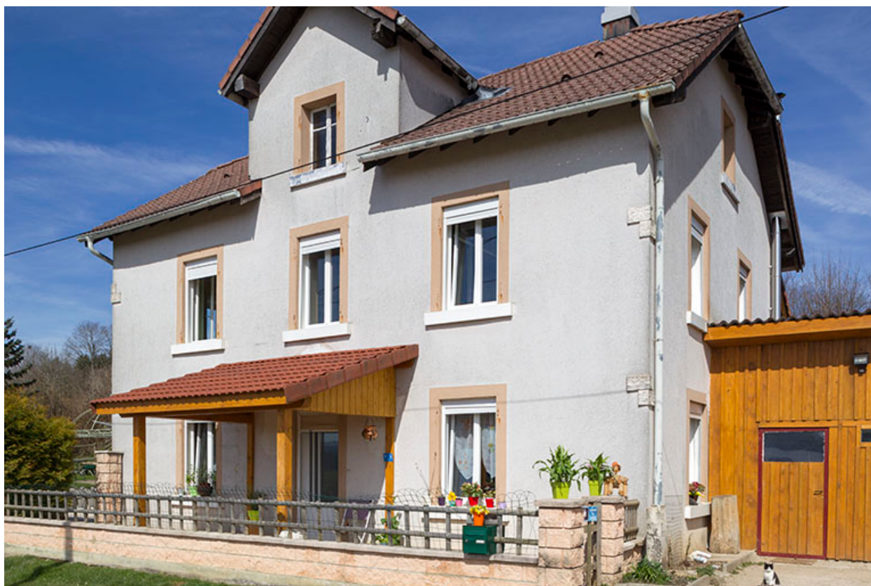
Façades antérieure et latérale droite.
