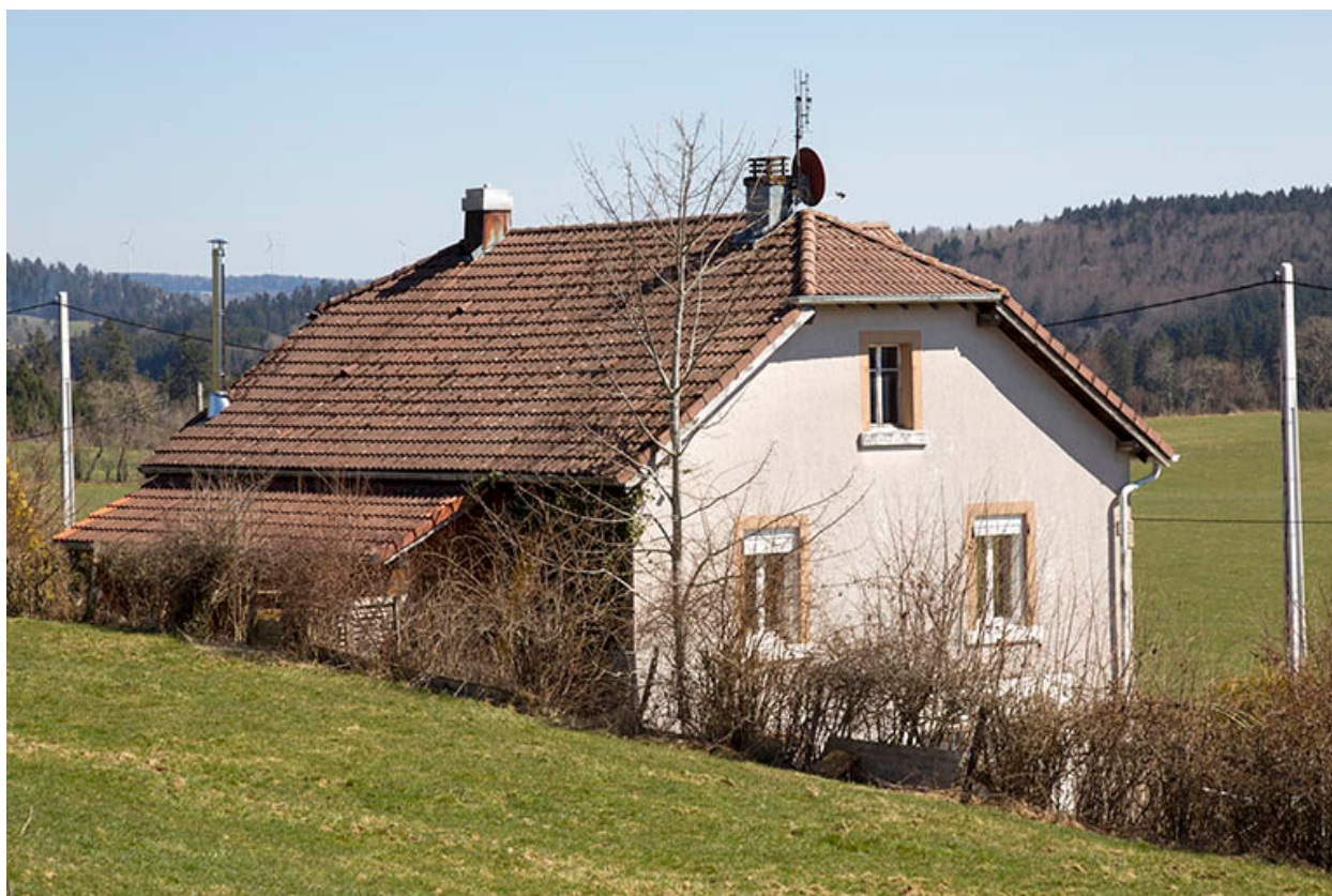
Façades postérieure et latérale droite.
