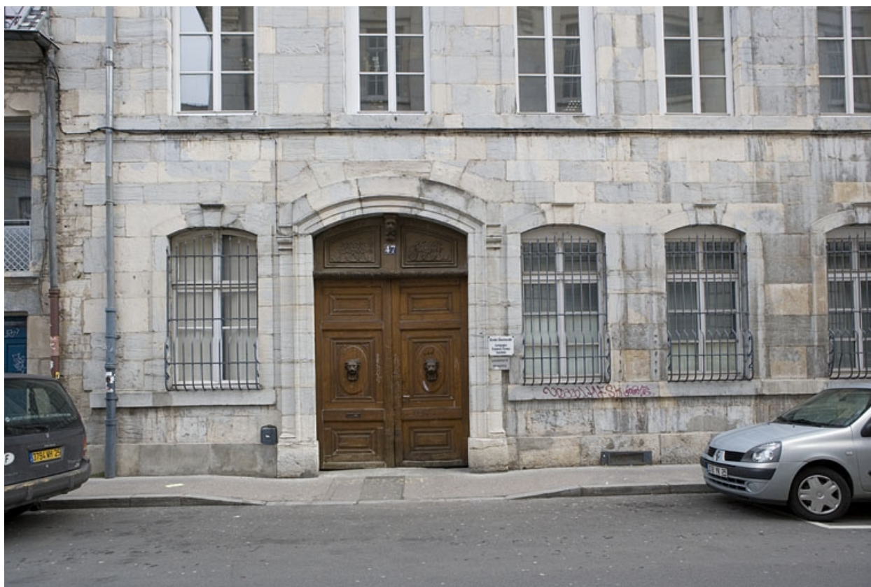
Détail du rez-de-chaussée de la façade principale.
