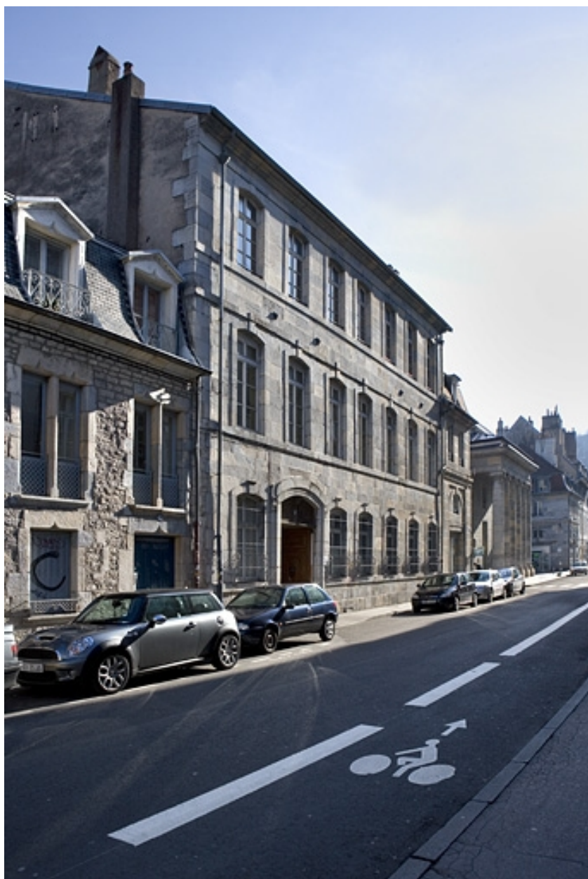
Vue d'ensemble rapprochée de la façade antérieure.
