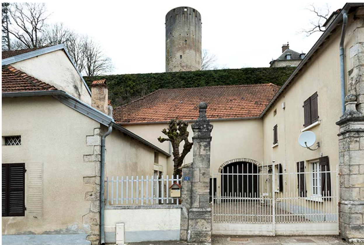
Vue générale depuis la rue du Pâquis
