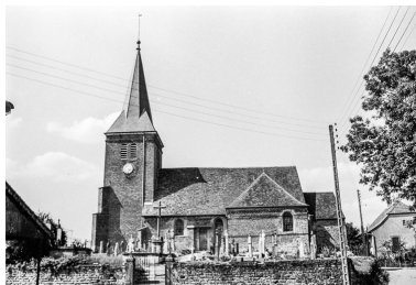
Façade latérale gauche. Phot. Guy Forestier IVR43_19753900150Z
