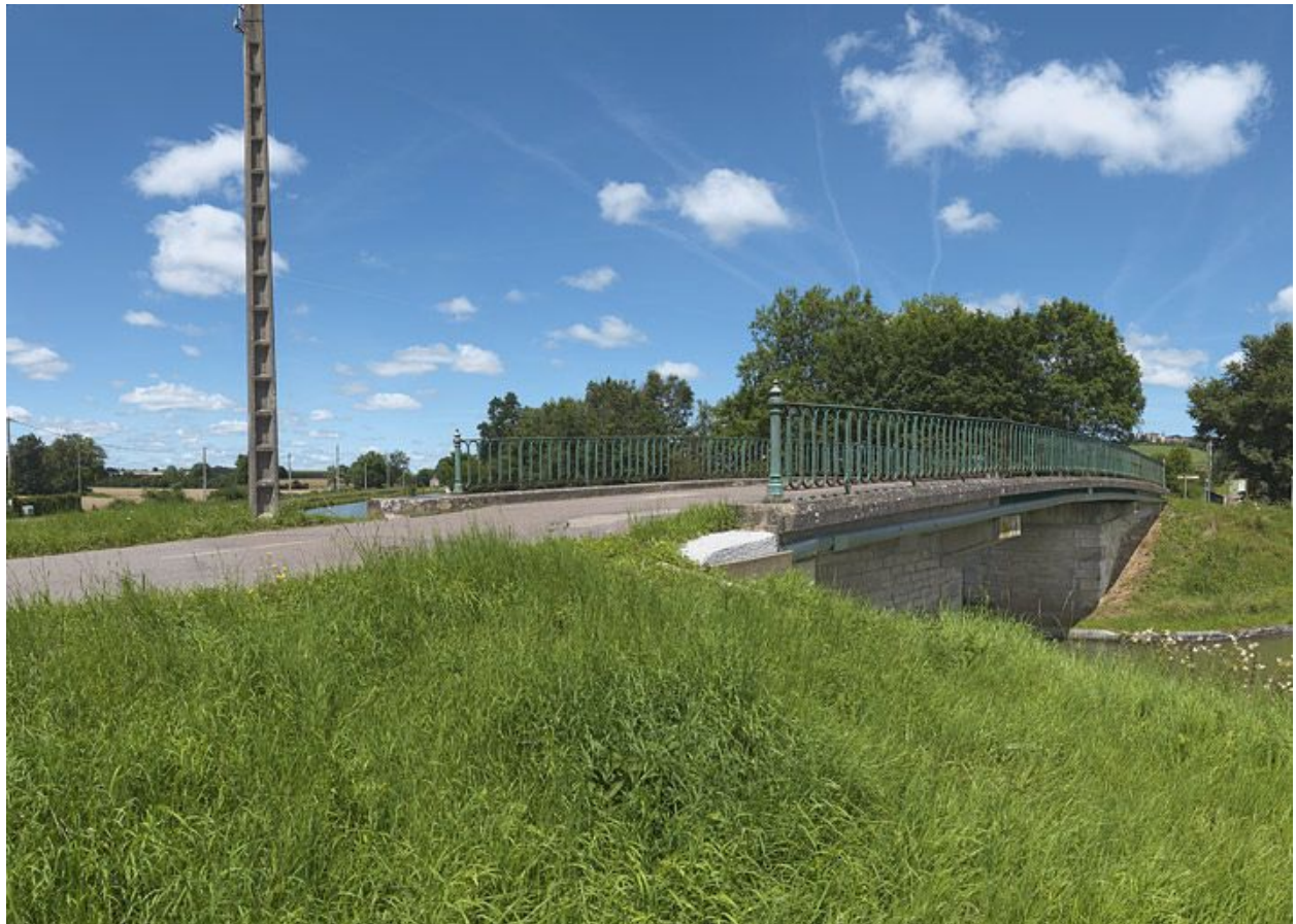
Le pont routier vu d'aval.
