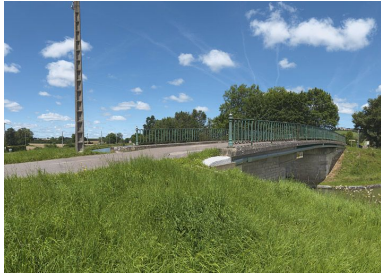
Le pont routier vu d'aval.
