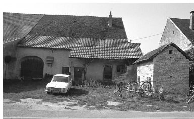
Vue principale. Phot. Bernard Lardière IVR43_19797000103Z
