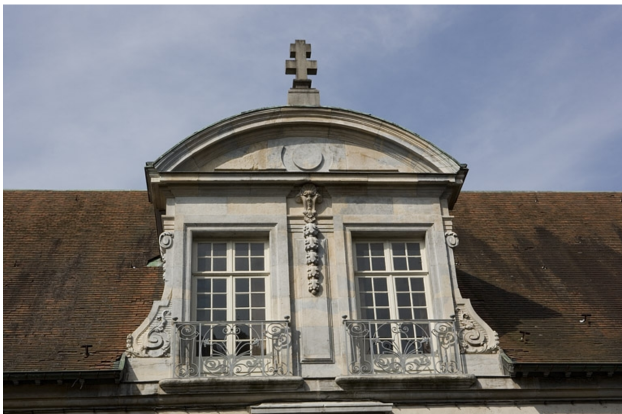
Détail d'une mansarde.
