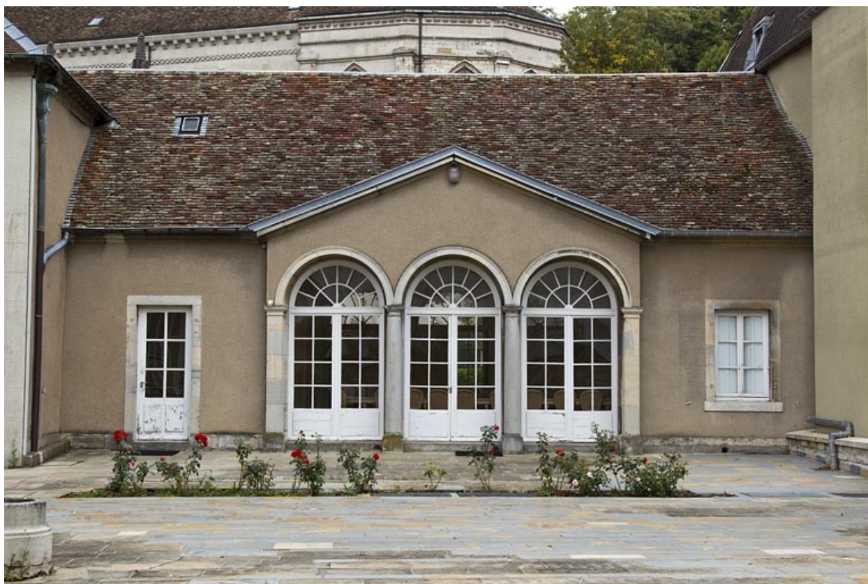
Orangerie : vue d'ensemble de la façade antérieure.
