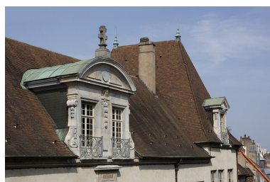
Détail d'une mansarde de trois quarts gauche. Phot. Yves Sancey IVR43_20072500473NUCA
