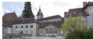
Orangerie : vue d'ensemble éloignée, de face.
