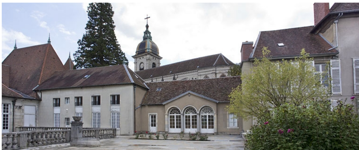
Orangerie : vue d'ensemble éloignée, de face.
