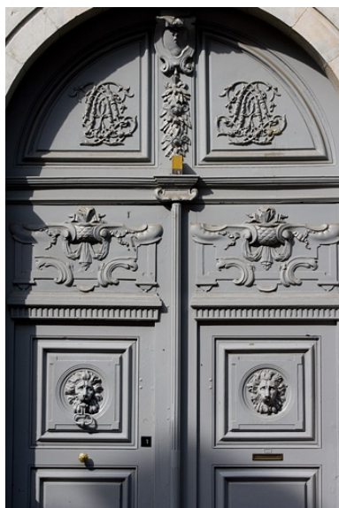
Vue d'ensemble des vantaux du portail d'entrée. Phot. Yves Sancey IVR43_20072500463NUCA
