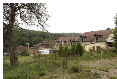
Halle et logements d'ouvriers depuis le sud-est. Phot. Jérôme Mongreville IVR43_20067000692NUCA
