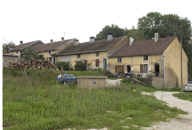
Logements d'ouvriers. Phot. Jérôme Mongreville IVR43_20067000694NUCA
