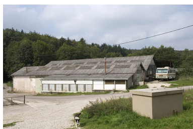
Emplacement de l'ancien atelier de forge. Phot. Jérôme Mongreville IVR43_20067000696NUCA
